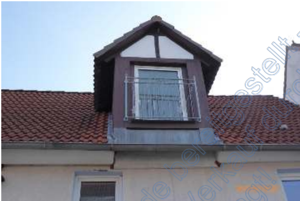
Foto 3: Ansicht der straßenseitigen Dachgaube
