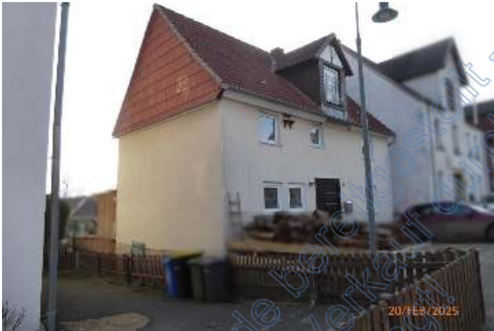
Foto 1: Ansicht aus nordwestlicher Richtung
