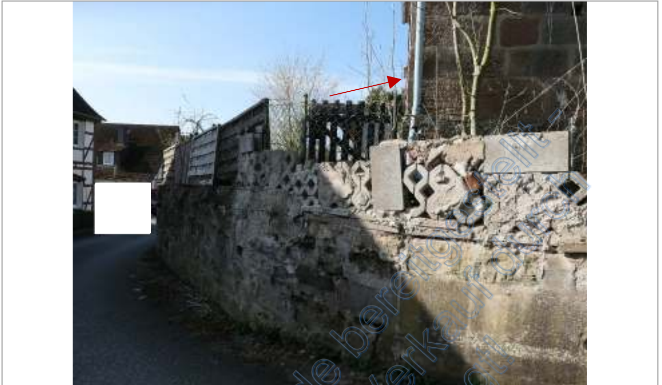
Bild 9: Grundstücksbegrenzung Straße „Katthagen“
