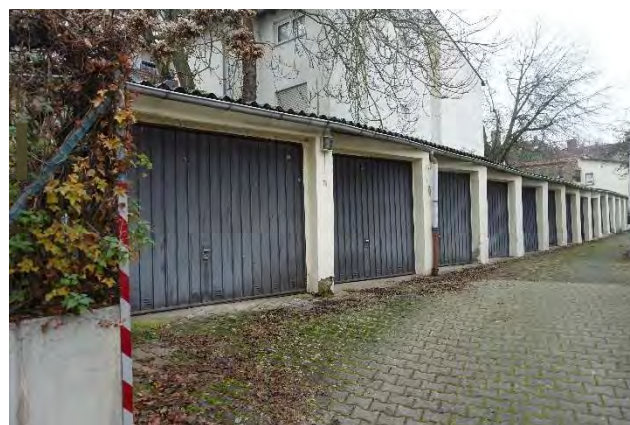
7.4.6 Garagen und Fahrspur, Blick von der Zu- und Ausfahrt zum Flurstück 36/9 Richtung Nordosten
