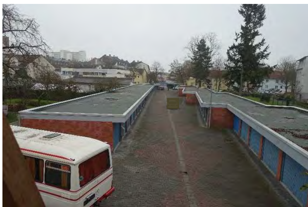
7.4.3 Flurstück 36/9, Erschließungsfahrspur, Blick vom Flurstück 24/28 Richtung Südosten
