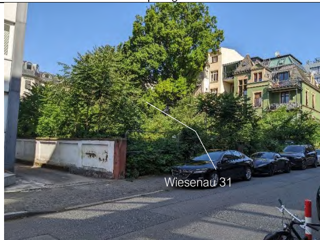
Straßenansicht, Blick vom gegenüberliegenden Gehweg Richtung Nordwesten
