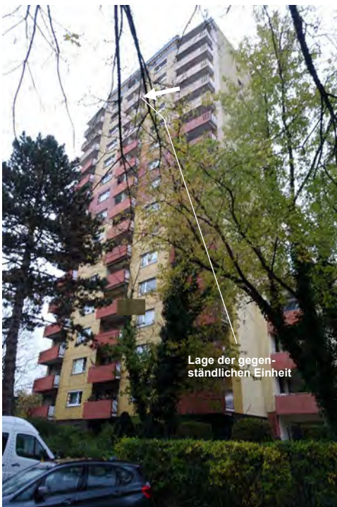
9.5.3 Südwest- und Südostfassade, Blick von den südwestlichen Stellplätzen Richtung Norden
