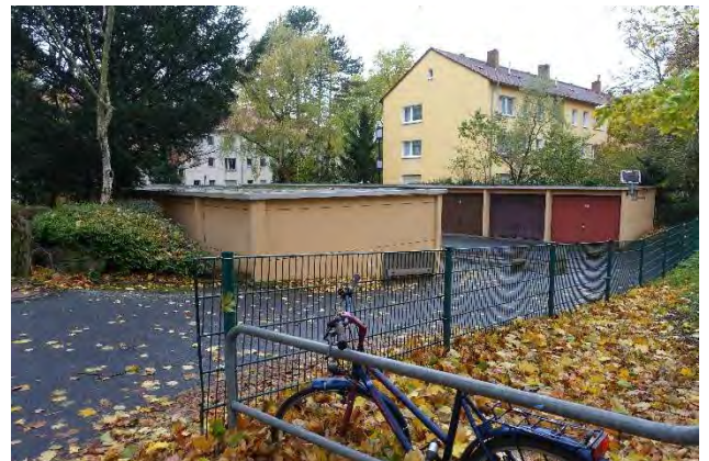
9.5.14 Nördliche und östliche Grundstücksgrenzen, Reihengaragen im nördlichen Grundstücksbereich, Blick Richtung Westen
