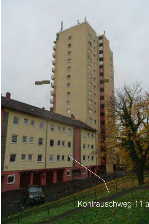
9.5.1 Südost- und Nordostfassaden, Blick von der Ludwig-Landmann-Straße Richtung Westen
