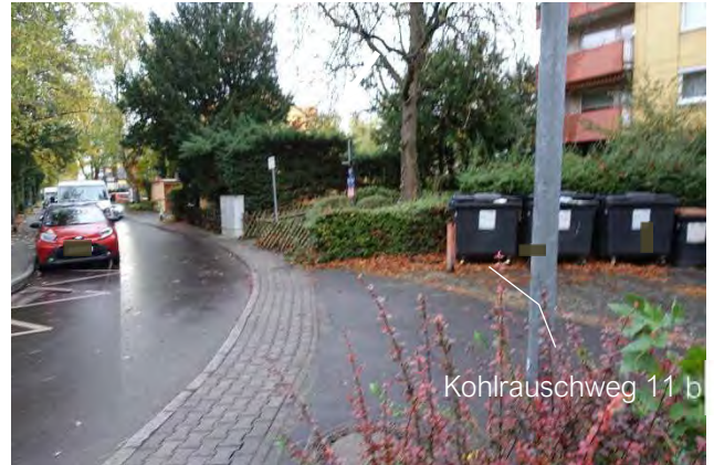
9.5.12 Südwestfassade, Freianlage, westliche Grundstücksgrenze, Zufahrt zu den südwestlichen Stellplätzen, Blick Richtung Norden
