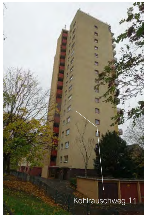
9.5.4 Nordwest- und Nordostfassaden, Blick von der Ludwig-Landmann-Straße Richtung Süden
