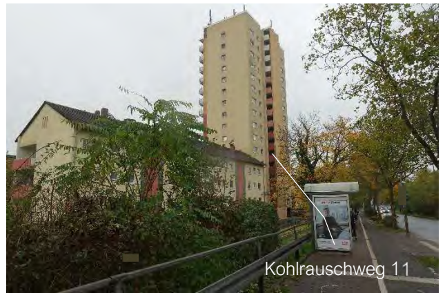
9.5.6 Südost- und Nordostfassaden, Blick von der Ludwig-Landmann-Straße Richtung Westen
