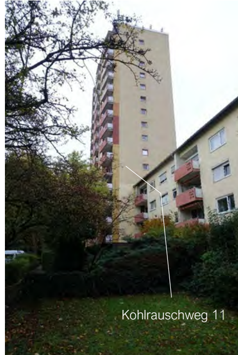
9.5.2 Südwest- und Südostfassade, Blick von der südwestlichen Freifläche Richtung Nordwesten
