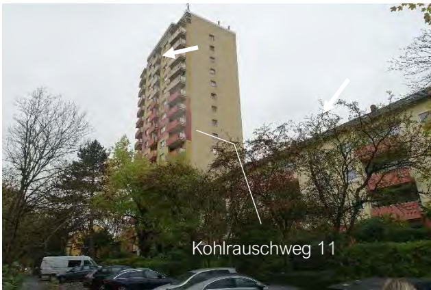
9.5.5 Südost- und Südwestfassaden, Blick von den südwestlichen Stellplätzen Richtung Norden
