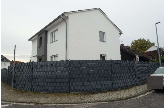
Nordost- und Nordwestfassade, Grundstücksgrenze, Blick von der Kreuzung Klarastraße / Eifelstraße Richtung Süden
