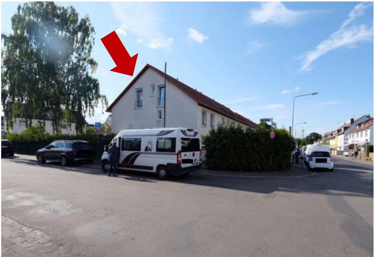
Blick zur Südfassade des Bewertungsobjekts (Reihenendhaus).
