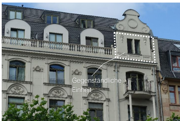
9.3.7 Nordostfassade, Blick vom Jürgen-Ponto-Platz Richtung Westen
