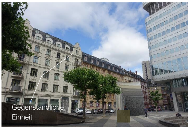
9.3.5 Nordostfassade, Blick vom Jürgen-Ponto-Platz Richtung Westen
