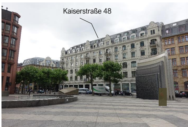
9.3.3 Nordostfassade, Blick vom Jürgen-Ponto-Platz Richtung Süden
