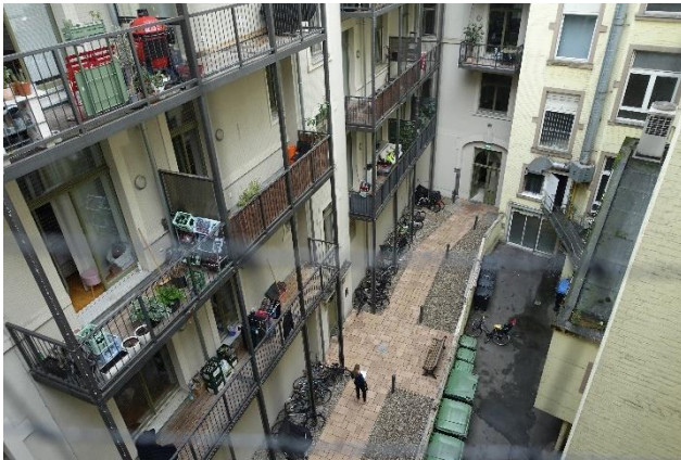
9.3.15 Südwest- und Nordwestfassade zum Innenhof, Blick Richtung Südosten
