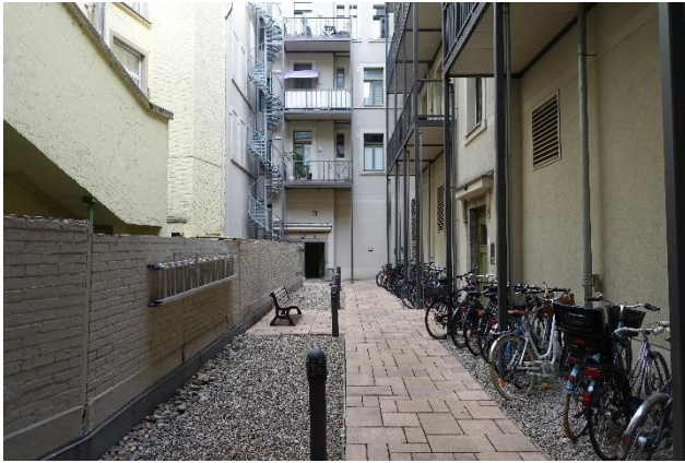
9.3.13 Südostfassade zum Innenhof, Blick Richtung Nordwesten
