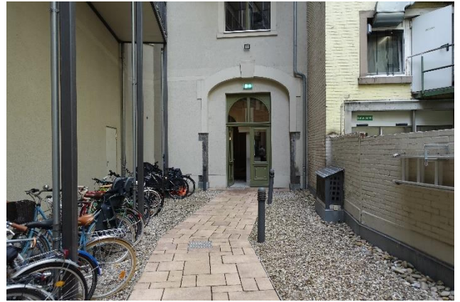
9.3.14 Nordwestfassade zum Innenhof, Blick Richtung Südosten
