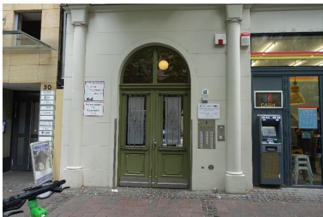
9.3.11 Hauseingang von der Kaiserstraße
