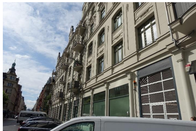
9.3.12 Nordostfassade zur Weserstraße, Tor zur Parkgarage
