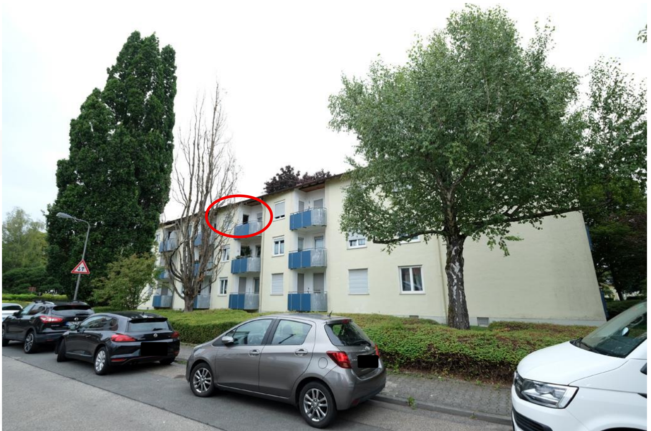
Westfassade der Wohnanlage Bielefelder Straße 1-5. Das Bewertungsobjekt im II.OG, Haus Nr. 3 ist markiert.
