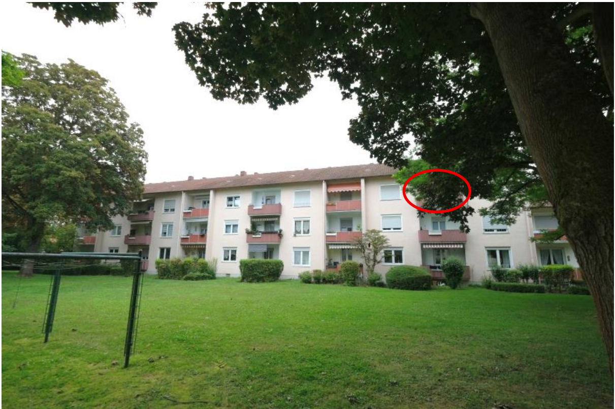
Westfassade der Wohnanlage Bielefelder Straße 7-13. Das Bewertungsobjekt im II.OG, Haus Nr. 9 ist markiert.
