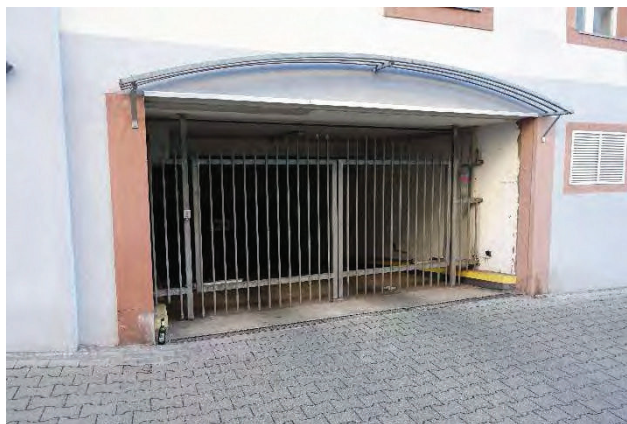
8.4.12 Garagentor zur Amtsgasse
