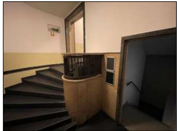
Vorderhaus – Treppenhaus Wohnen EG
