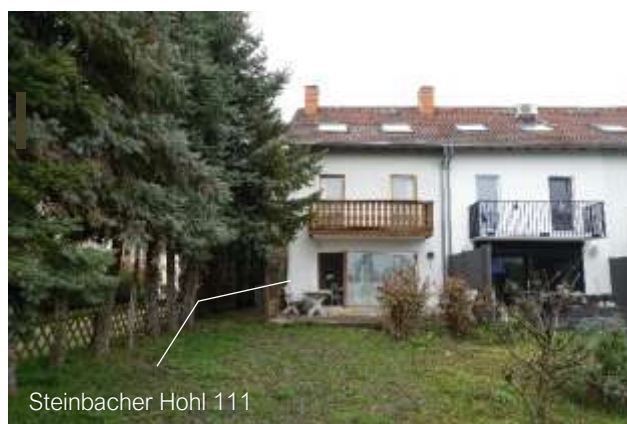
10.5.6 Südwestfassade, Terrasse, Blick vom Grundstück Richtung Nordosten
