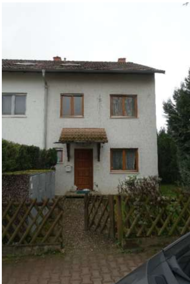
10.5.9 Nordostfassade, Blick von der Straße Richtung Nordwesten
