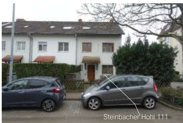
10.5.5 Nordostfassade, Blick von der Straße Richtung Südwesten
