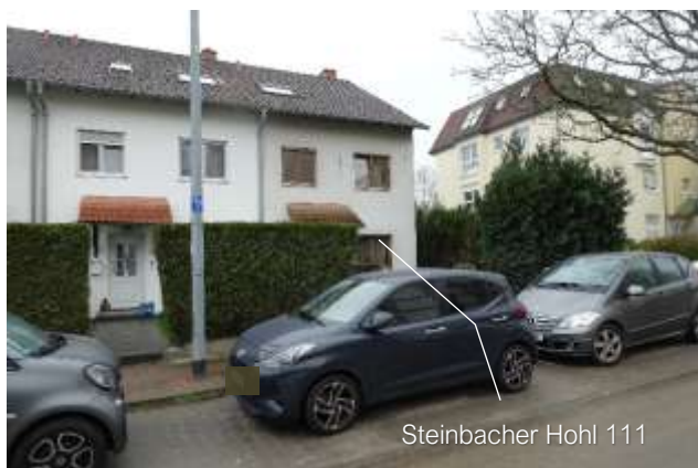
10.5.7 Nordostfassade, Blick von der Straße Richtung Nordwesten
