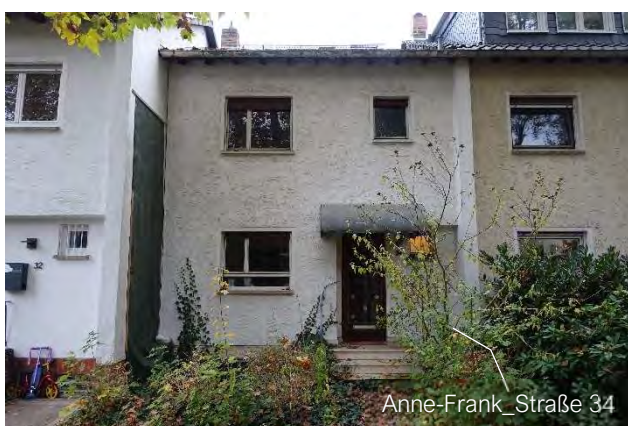
7.3.5 Nordostfassade, Blick vom nordöstlichen Erschließungsweg Flurstück 25/30 Richtung Südwesten
