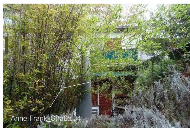
7.3.6 Südwestfassade, Terrasse, Blick vom Grundstück Richtung Nordosten
