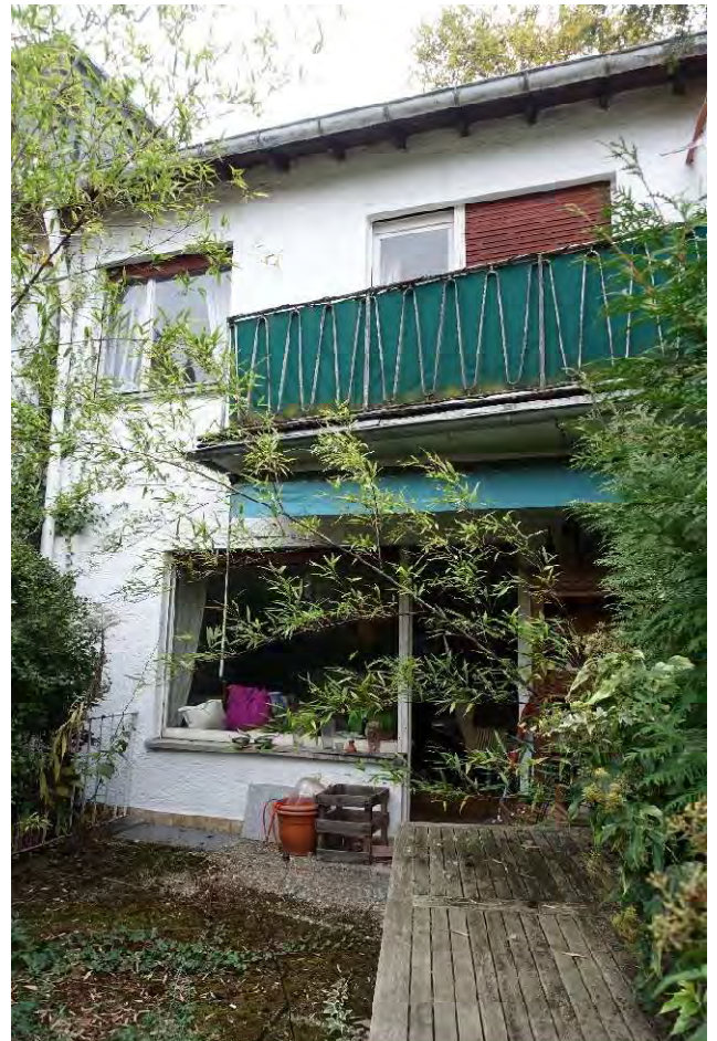
7.3.10 Südwestfassade, Terrasse, Blick vom Garten Richtung Norden
