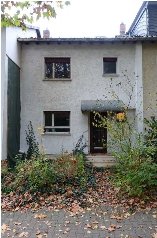
7.3.9 Nordostfassade, Blick vom nordöstlichen Erschließungsweg Flurstück 25/30 Richtung Südwesten
