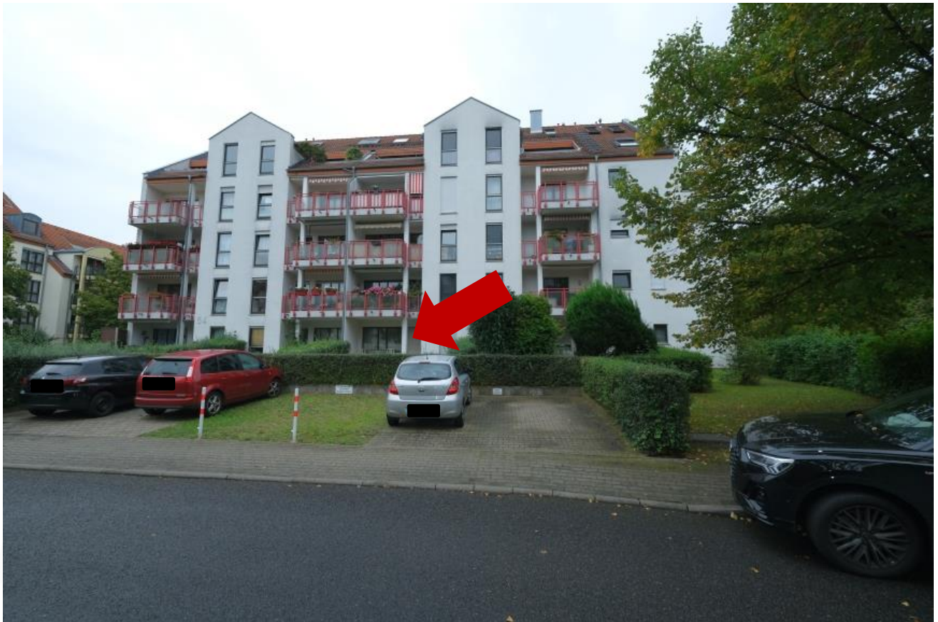
Westliche Straßenfassade zur Walter-Leiske-Straße. Die Wohnung Nr. 4 liegt im Erdgeschoss und ist markiert.
