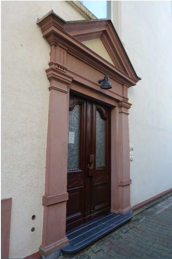
8.2.11 Hauseingang zum Haupttreppenhaus
