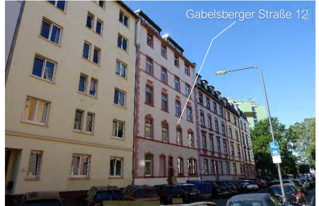
7.2.2 Gabelsberger Straße, Blick von der Kreuzung Ecke Eichwaldstraße Richtung Südwesten
