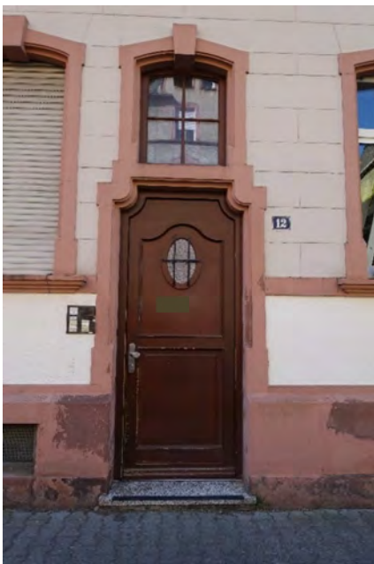
7.2.7 Straßenseitiger Hauseingang am Gehweg
