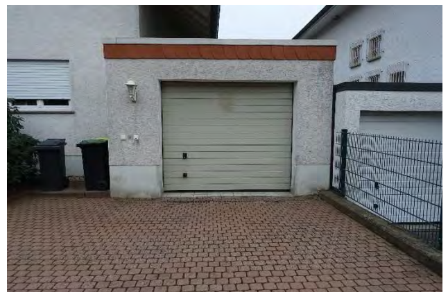
7.4.12 Zufahrt und Garage, Blick vom Gehweg der Sophie-Rosenthal-Straße Richtung Süden
