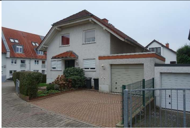
Nord- und Ostfassade, Garage an der westlichen Grundstücksgrenze, Blick vom Gehweg der Sophie-Rosenthal-Straße Richtung Südosten
