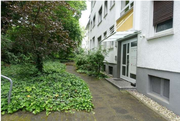
7.2.7 Nordfassade, Weg zum Hauseingang der Hausnummer 27, Blick Richtung Osten
