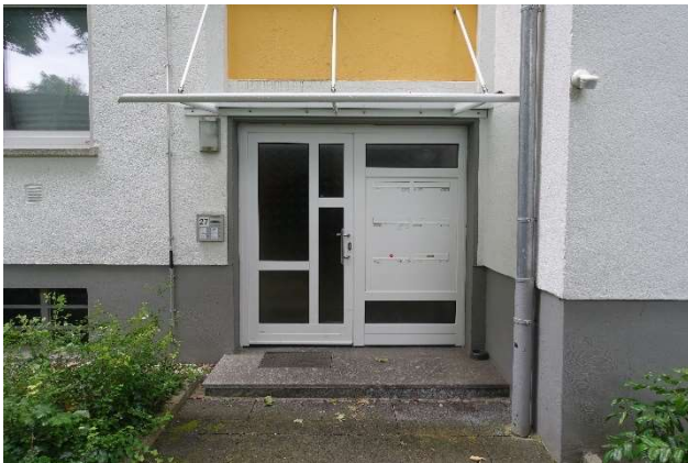
7.2.9 Hauseingang der Hausnummer 27
