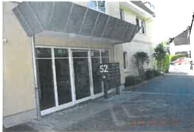
rückwärtiger Hauseingang Lorsbacher Straße 52
