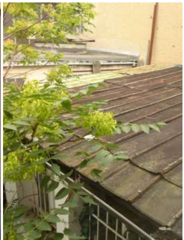
28 b Anbau an Hinterhaus im EG
