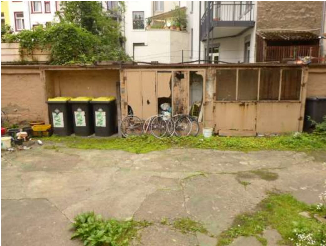
5 Zustand Hoffläche, abzutragende Bauteile
