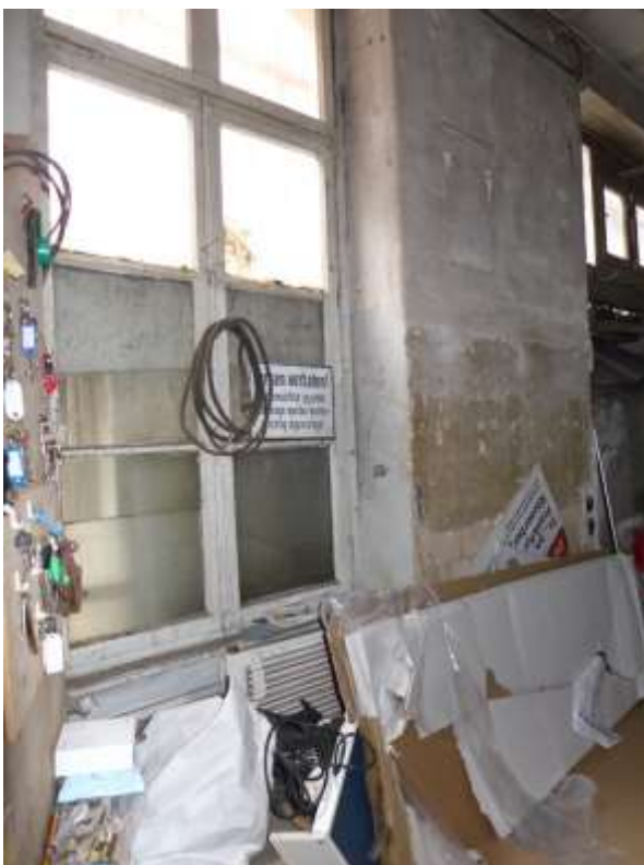
32 Fenster Hinterhaus Einheit EG links
