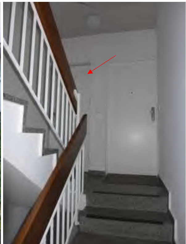
6 b Treppenhaus, Wohnungseingangstür zu Wohnungseigentum Nr. 2 im EG
