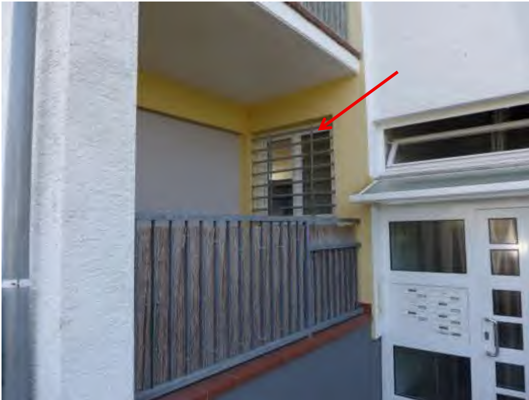
7 Hauseingangsbereich, Lage des Bewertungsobjekts
