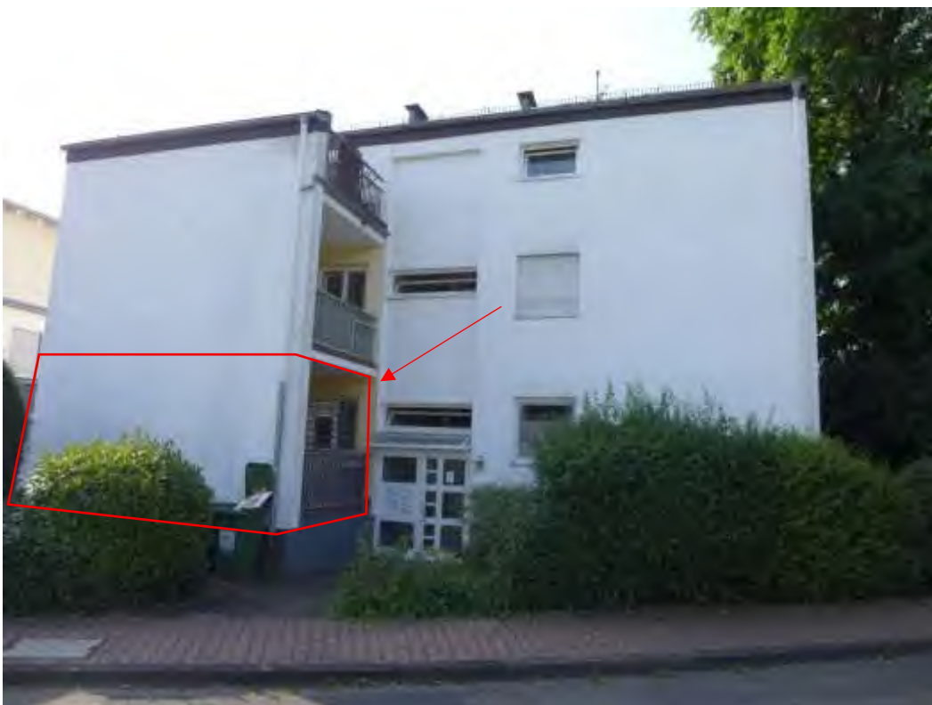
4 Straßen-/Seitenansicht (Nordostansicht), Lage des Bewertungsobjekts
