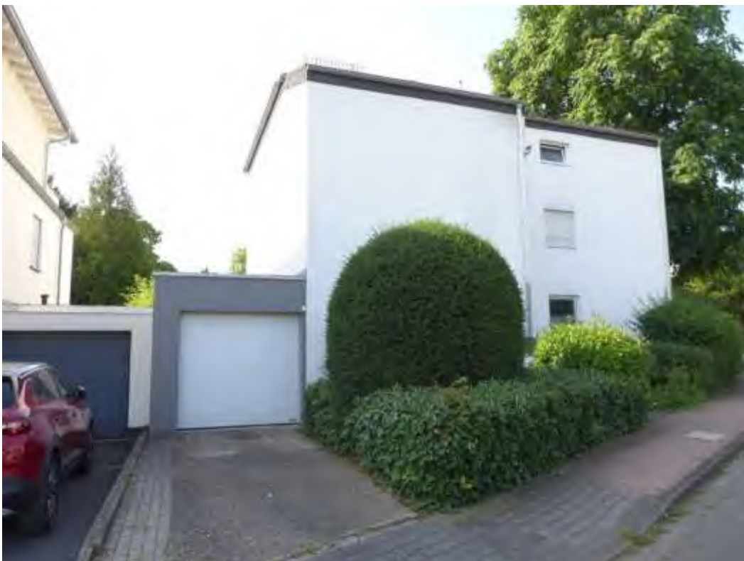
2 Straßen-/Seitenansicht (Garage gehört nicht zum Gesamtobjekt)
