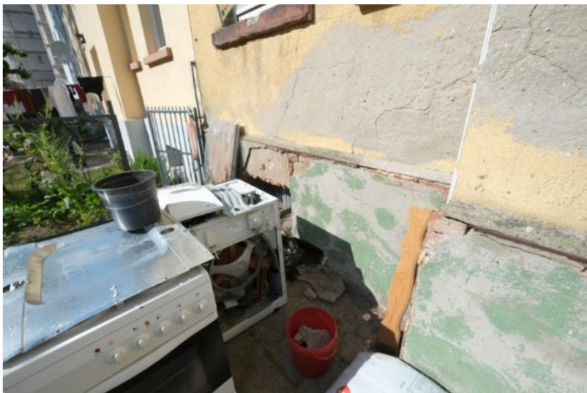
Sockelbereich zur Nordseite.
