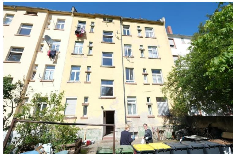
Die Hinterhoffassade weist Sanierungsbedarf auf. Multiple Riss- und Putzschäden vorhanden. Teilweise bröckeln die Sandstein-gesimse ab.
