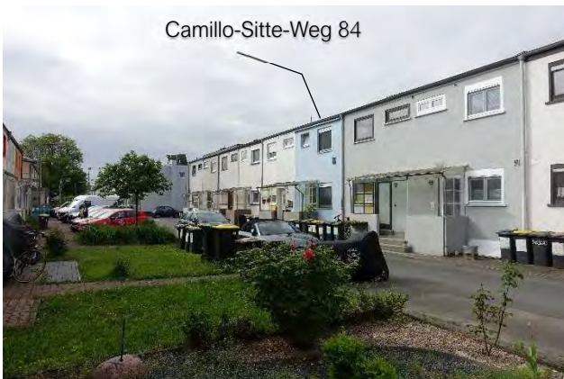
7.2.3 Nordostfassade, Blick vom Camillo-Sitte-Weg 73 Richtung Süden
