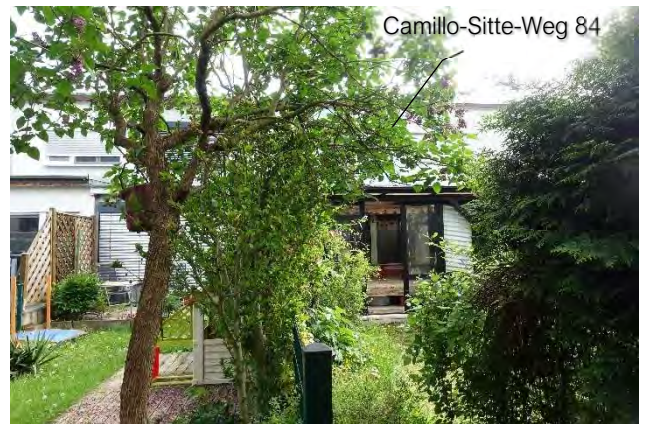
7.2.6 Garten und Südwestfassade, Blick vom Fußweg an der südwestlichen Grundstücksgrenze Richtung Osten
