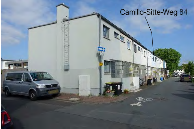
7.2.1 Südost- und Nordostfassaden, Blick von der Ecke „Am Ebelfeld“ Richtung Nordwesten
