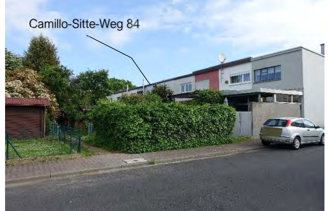
7.2.2 Südwestfassaden, Blick von der Straße „Am Ebelfeld“ Richtung Norden
