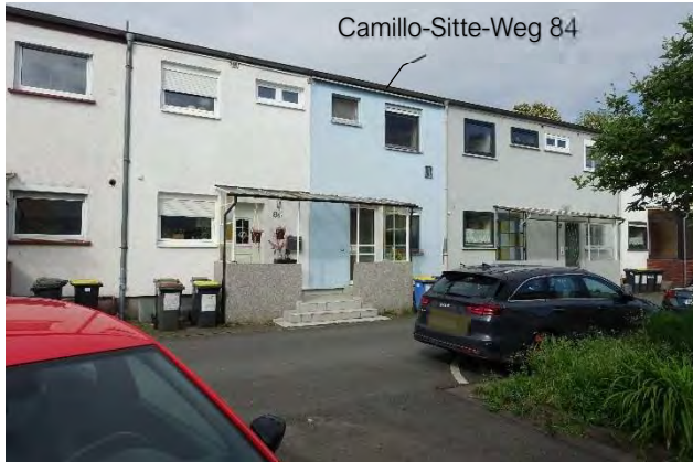
7.2.7 Nordostfassade, Blick von der Straße Richtung Westen
