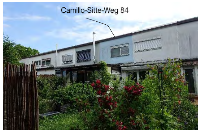
7.2.4 Garten und Südwestfassade, Blick vom Fußweg an der südwestlichen Grundstücksgrenze Richtung Norden
