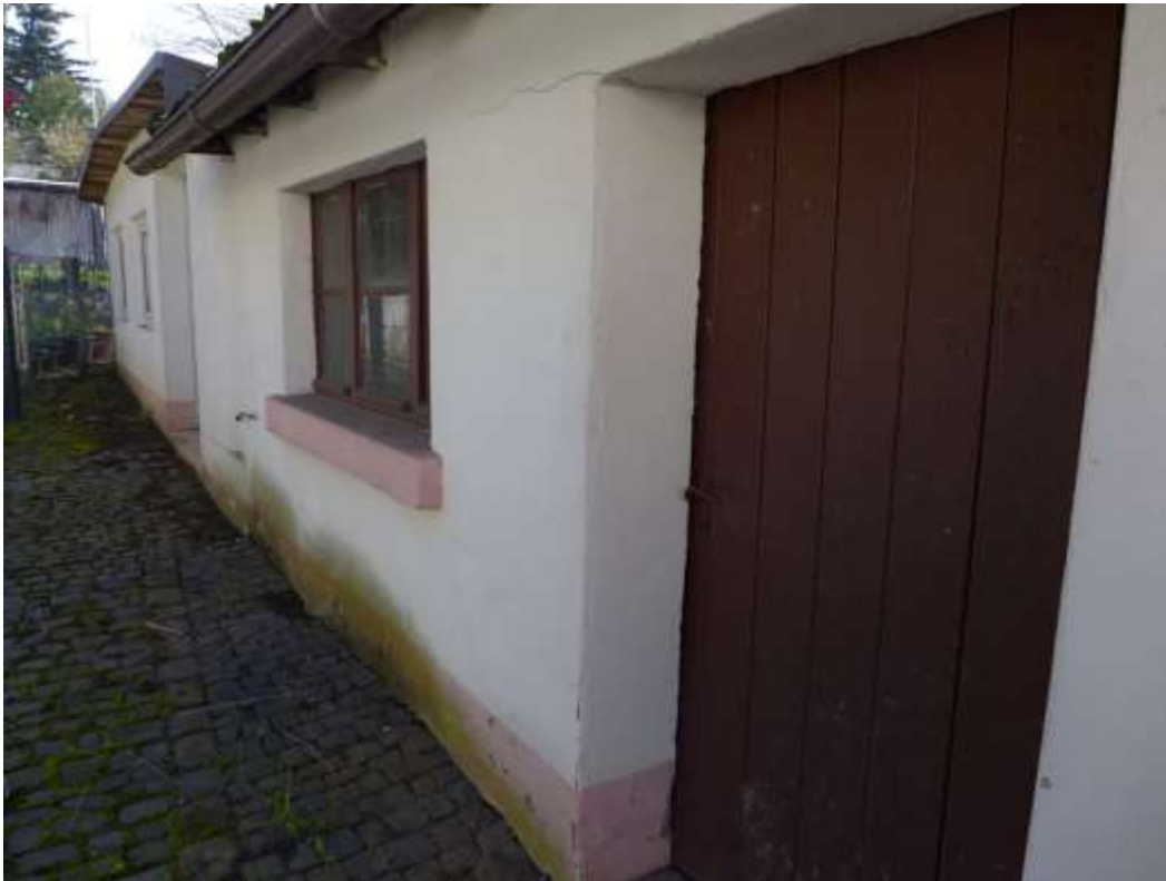
25 Nordansicht Gerätehaus (Flurstück 216/3 + 261/2)
