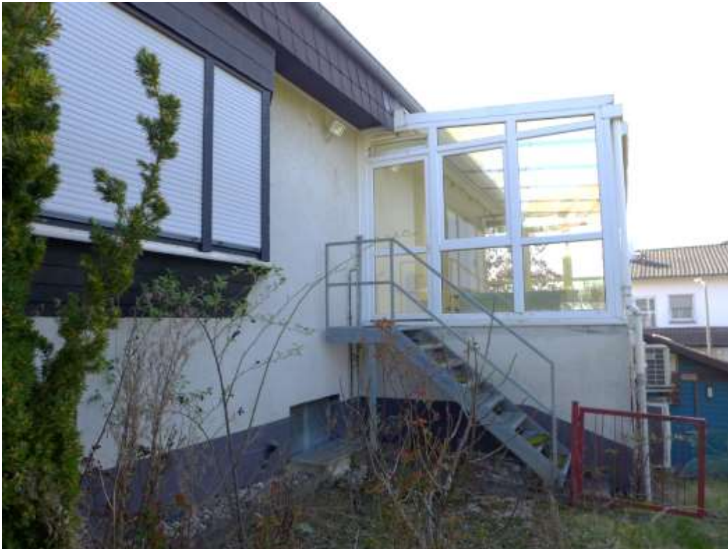
13 Westseite, Wintergarten mit Ausgangstreppe (Flurstück 261/2)
