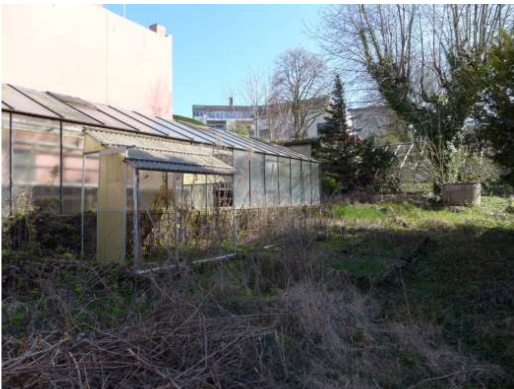
32 Gewächshaus (Flurstück 208/6), links: Brandwand Nachbargrundstück
