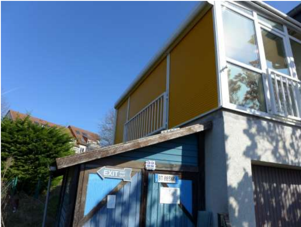
19 Südwestansicht Schuppen, Wintergarten (Flurstück 261/2)
