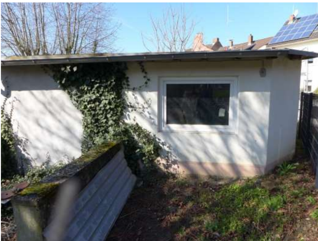
24 Ostansicht Gerätehaus (Flurstück 261/2)
