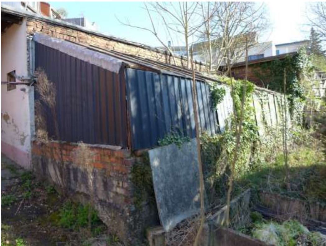
28 Südseite Gerätehaus (Flurstück 216/3 + 261/2) mit Raum für Öltank
