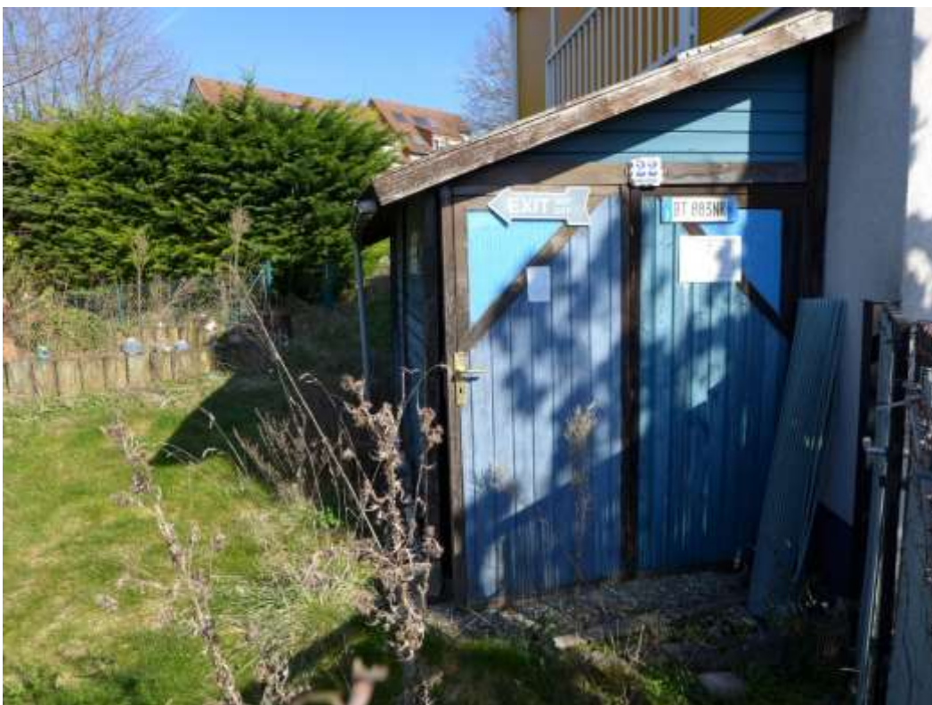
18 angebauter Schuppen (Flurstück 261/2)
