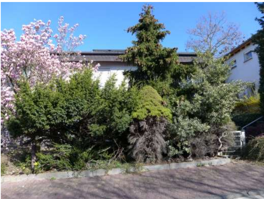
4 Straßenansicht Wohnhaus (Flurstück 261/2)
