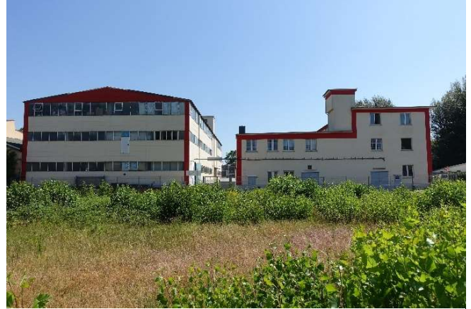
Nordwestfassaden, Blick vom westlichen Nachbargrundstück Richtung Nordosten
