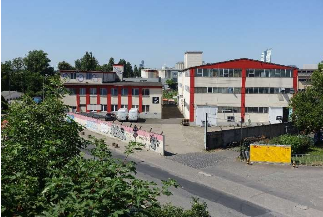
Nordostfassaden und Hof, Blick von der BAB 661 Richtung Südwesten
