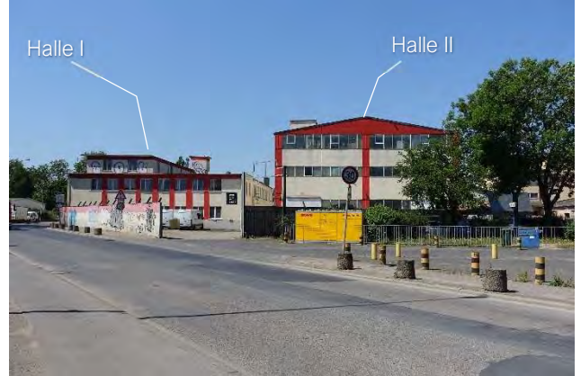
7.3.2 Nordostfassaden und Ein- und Ausfahrt, Blick von der Franziusstraße Richtung Südwesten
