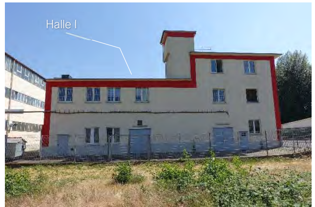
7.3.8 Nordwestfassade und Grundstücksgrenze, Blick vom westlichen Nachbargrundstück Richtung Nordosten
