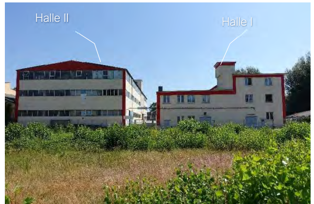
7.3.4 Nordwestfassaden und Grundstücksgrenze, Blick vom westlichen Nachbargrundstück Richtung Nordosten
