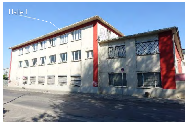
7.3.6 Südostfassade, Blick von der Franziusstraße Richtung Nordwesten
