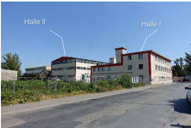
7.3.3 Südwest- und Südostfassaden, Blick von der Franziusstraße Richtung Nordosten
