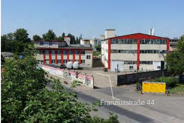
7.3.1 Nordostfassaden und Hof, Blick von der BAB 661 Richtung Südwesten
