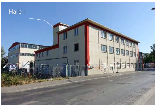
7.3.5 Südwest- und Südostfassade, Blick von der Franziusstraße Richtung Norden
