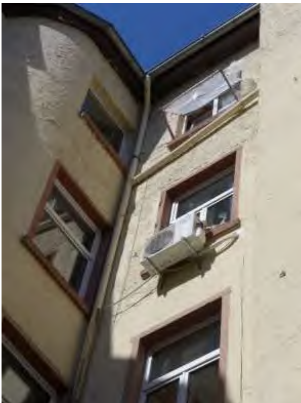
44 a Fassadenschäden, Klima-Splitt-Gerät
