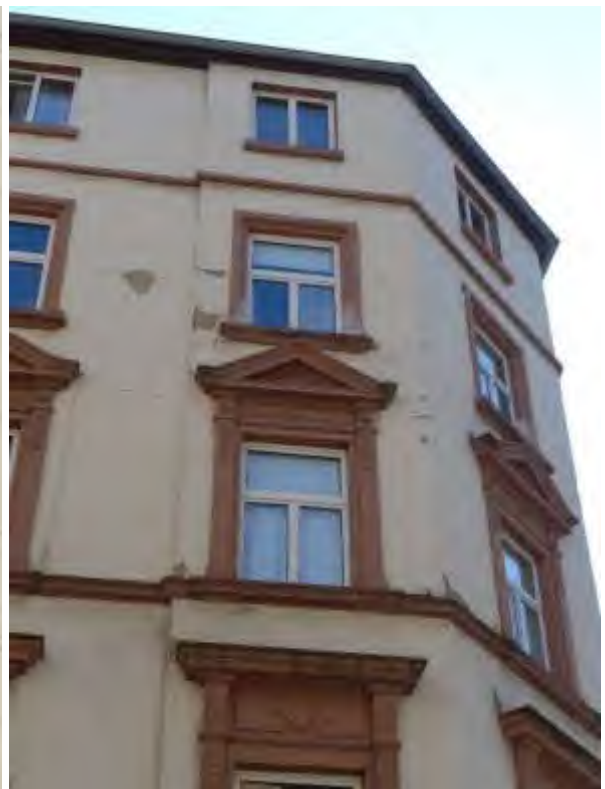
44 b Fassadenschäden
