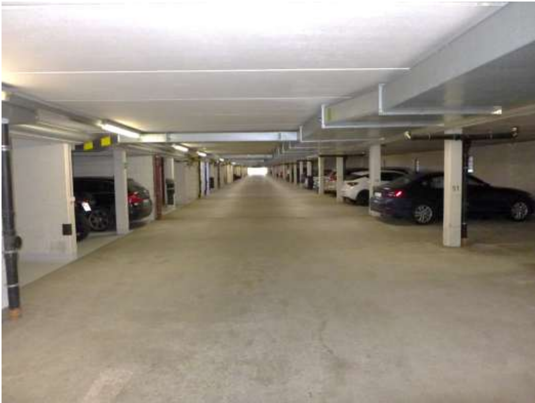
9 Tiefgarage über mehrere Grundstücke hinweg
