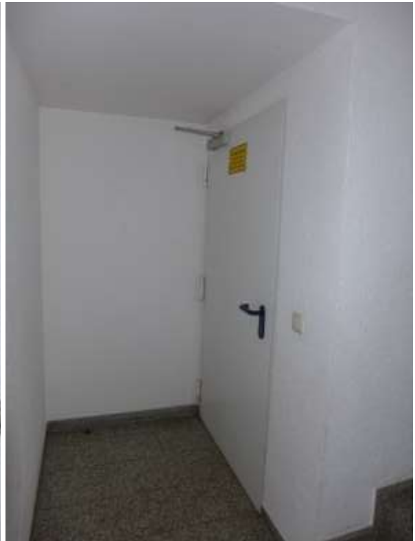
5 b Treppenhaus, Zugang Tiefgarage
