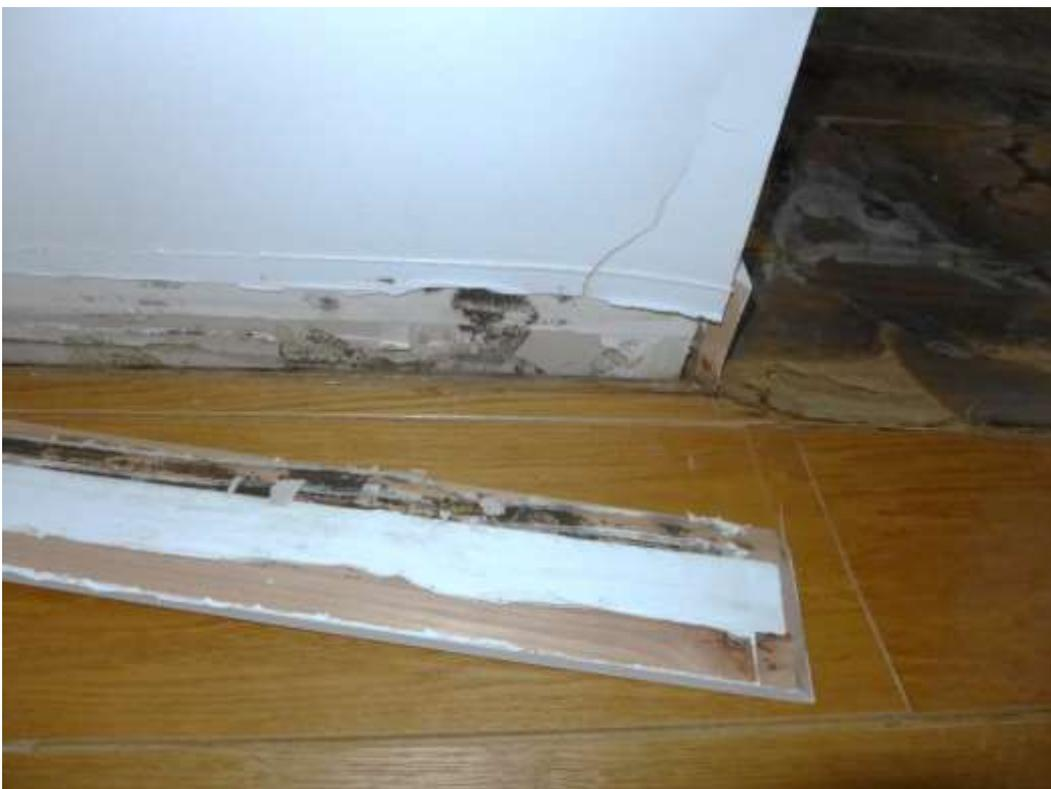
24 Schimmelbildung durch Wasserschaden Bereich Sockelleiste
