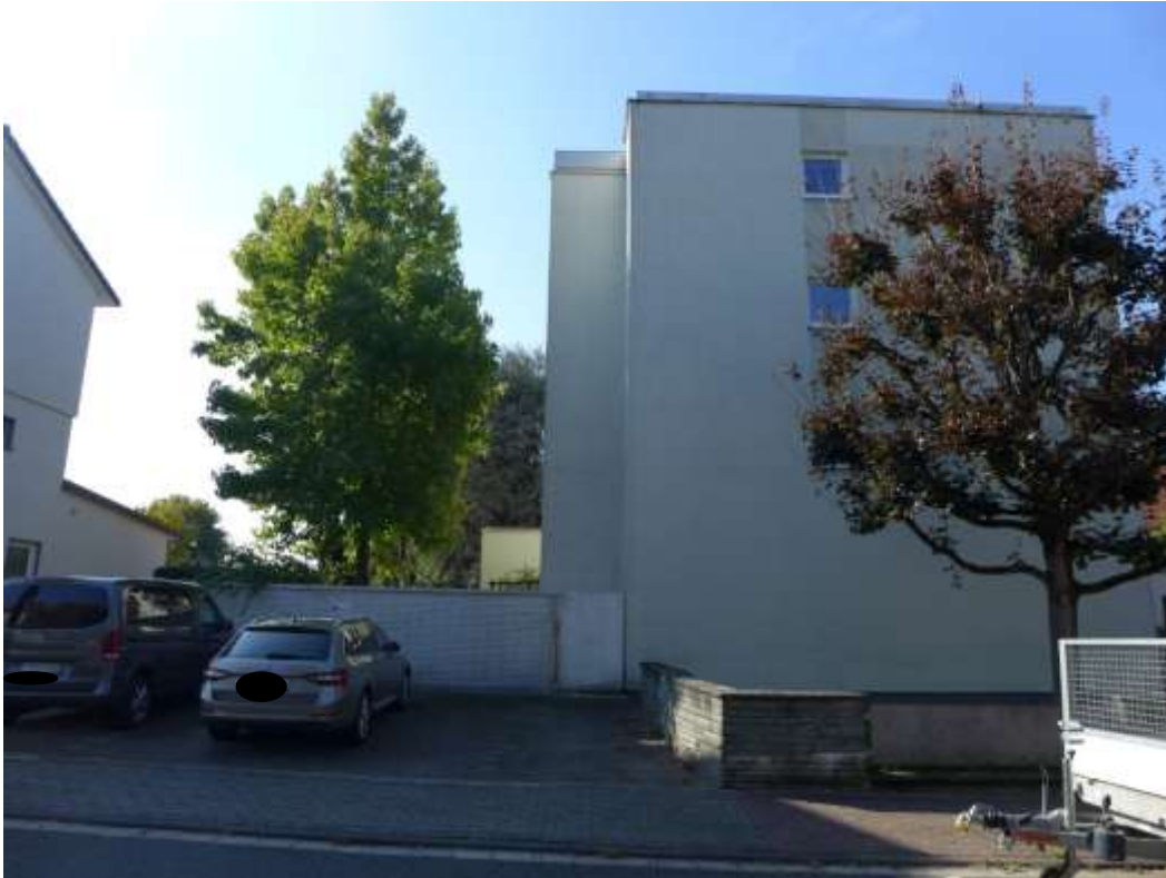
5 Straßenansicht (Nordostansicht), Stellplatzfläche links im Bild
