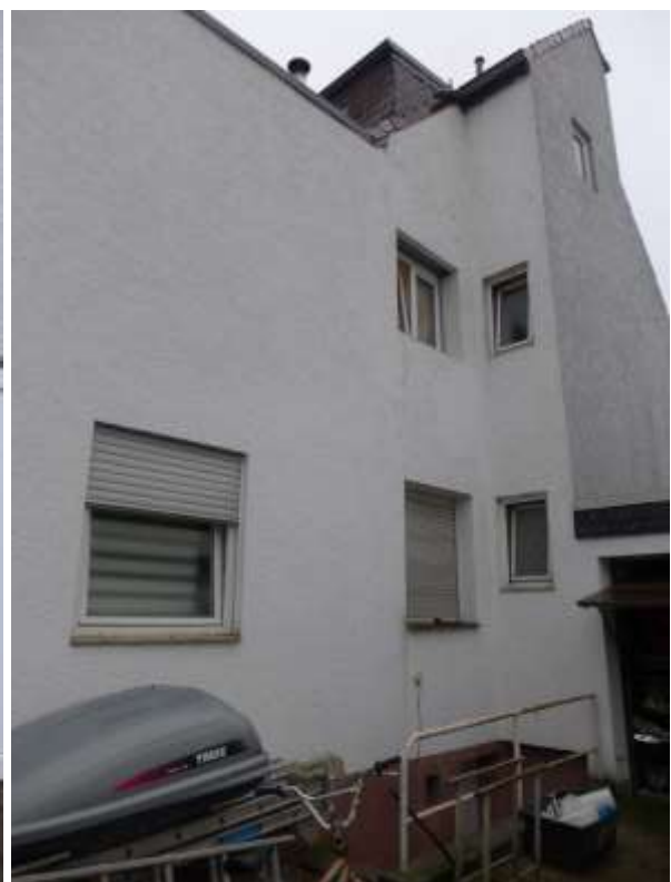
8 b Seitenansicht (Nordseite)
