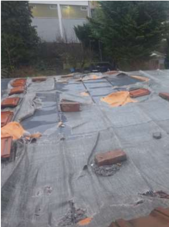
17 Dach des Anbaus mit provisorischer Folie belegt
