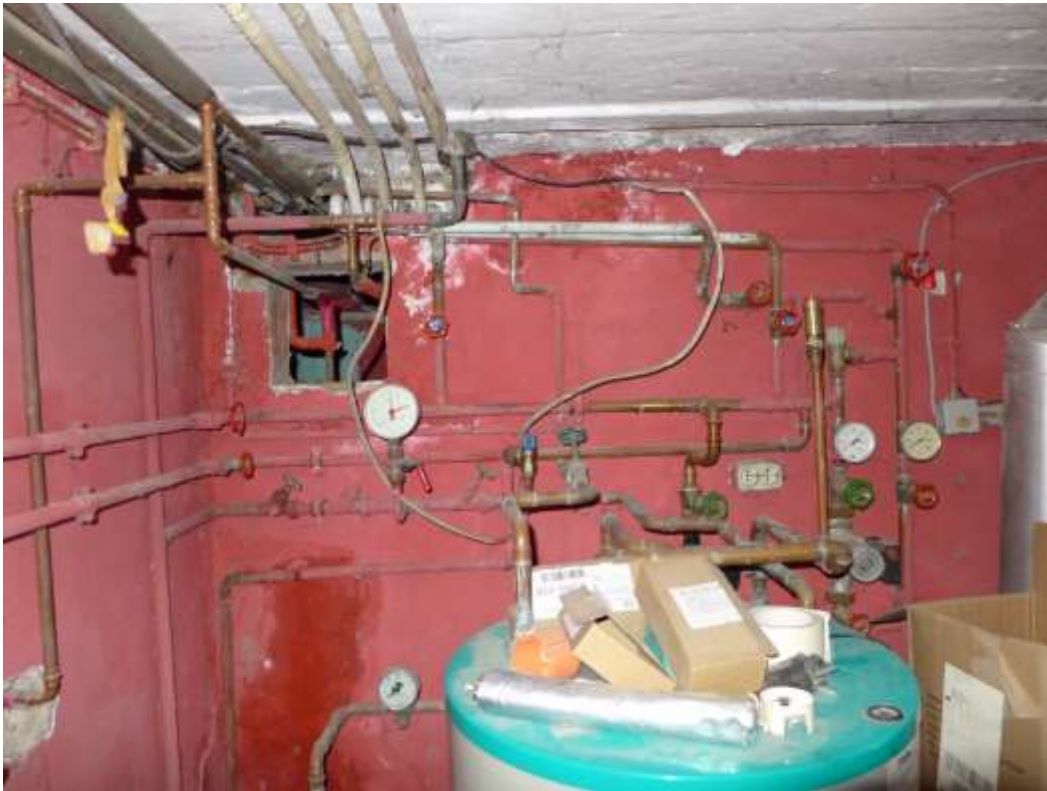
11 Wasser- und Heizungsinstallation
