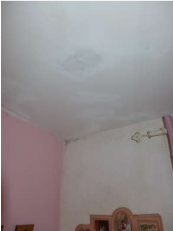
21 a Feuchtigkeitsflecken, Schimmel in Ecke 21 b Bodenbelag Wohnung EG
