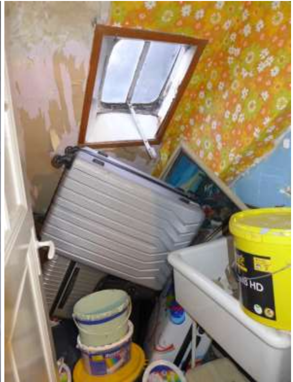
15 b Abstellraum Wohnung DG
