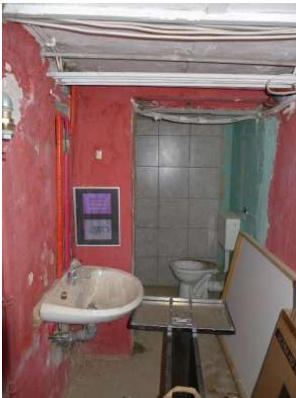
12 a Zustand Keller
