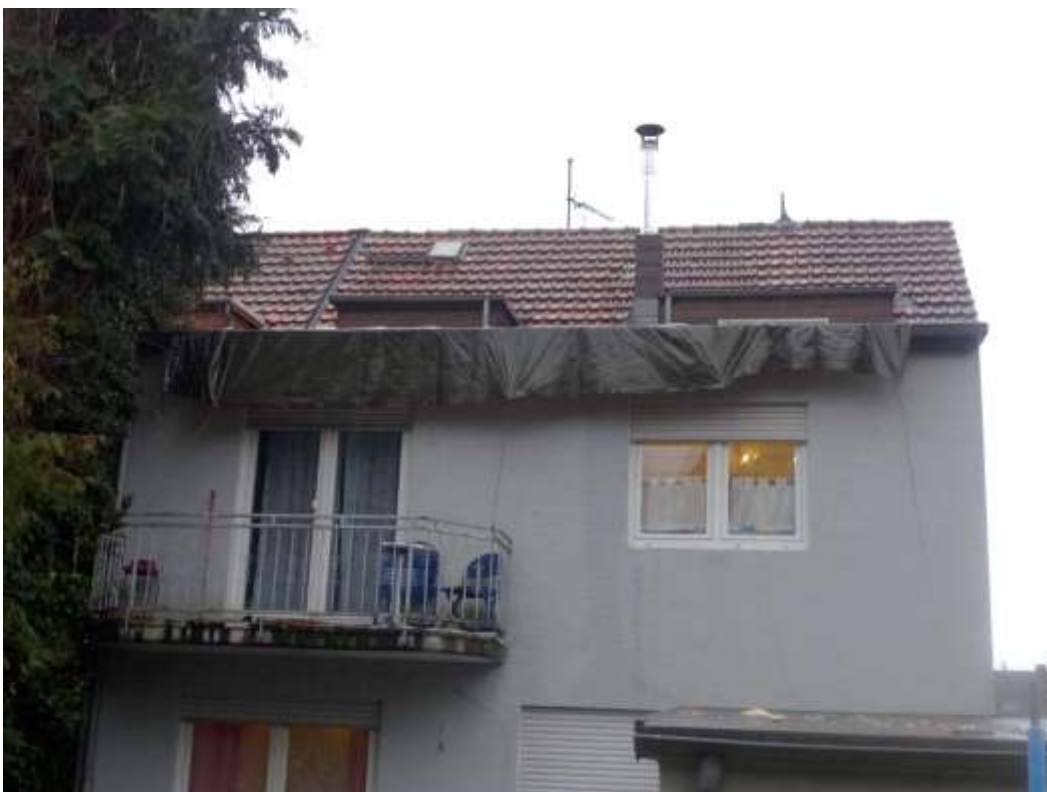
4 Rückansicht Ober- und Dachgeschoss (Ostseite)
