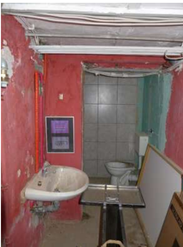
12 a Zustand Keller
