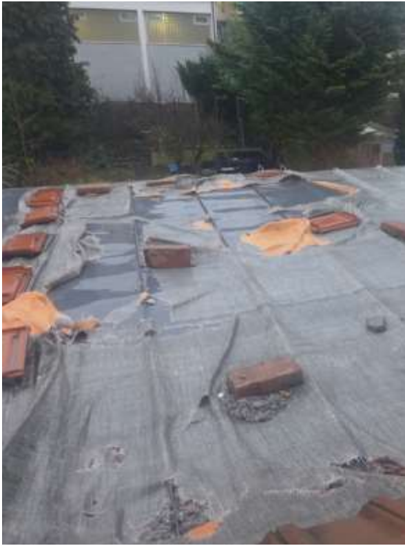
17 Dach des Anbaus mit provisorischer Folie belegt
