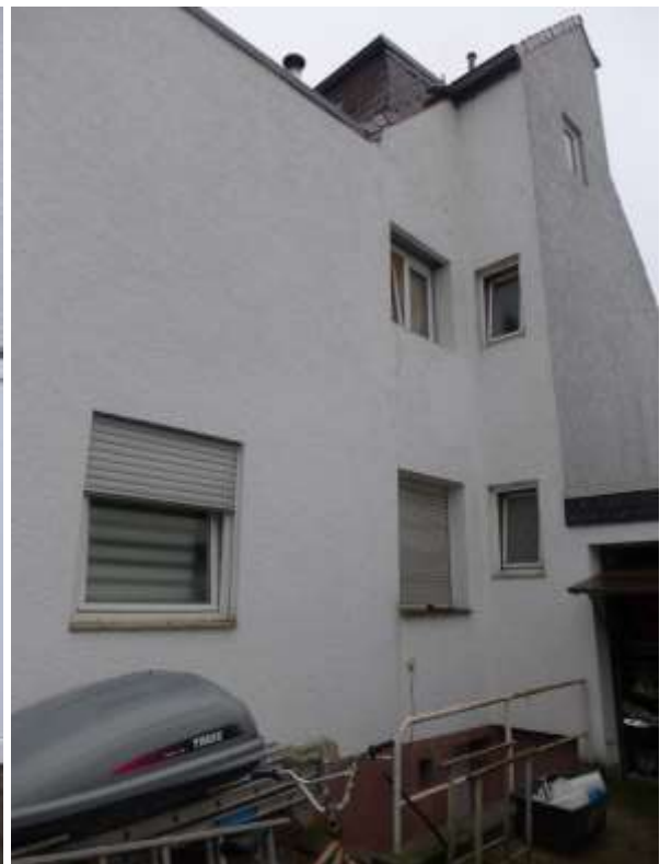
8 b Seitenansicht (Nordseite)
