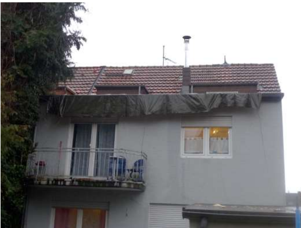
4 Rückansicht Ober- und Dachgeschoss (Ostseite)
