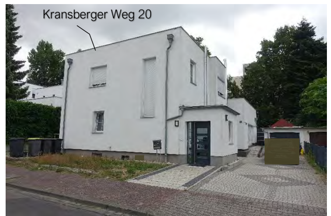
7.2.4 West- und Südfassade, Blick von der Straße Richtung Nordosten
