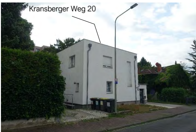
7.2.3 Nord- und Westfassade, Blick von der Straße Richtung Südosten
