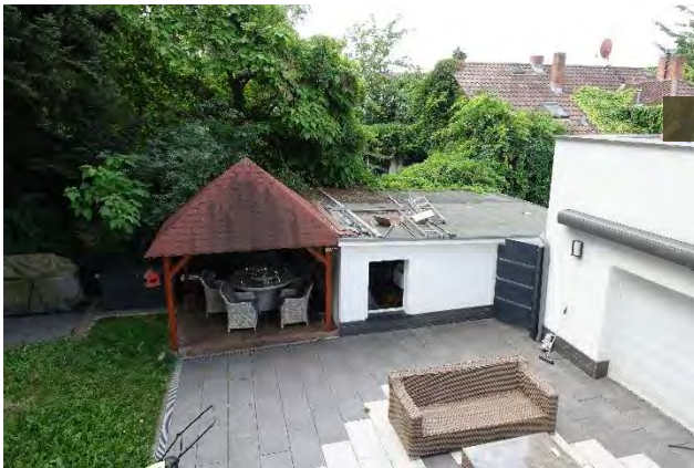
7.2.9 Terrasse, Gartenpavillon, Garage, Ostfassade Anbau, Blick von der Dachfläche Anbau Richtung Süden
