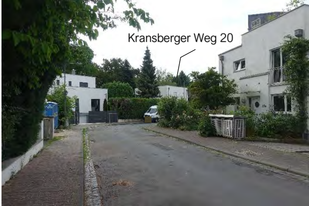
7.2.1 Nord- und Westfassade, Blick von der Straße Richtung Südosten
