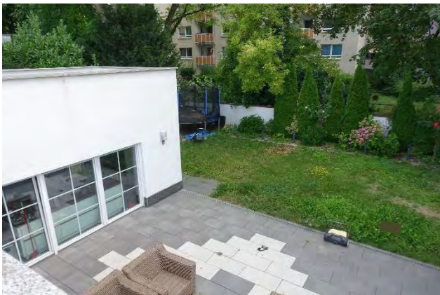
7.2.11 Südfassade Anbau, Terrasse, Garten, Blick von der Dachfläche Anbau Richtung Nordosten
