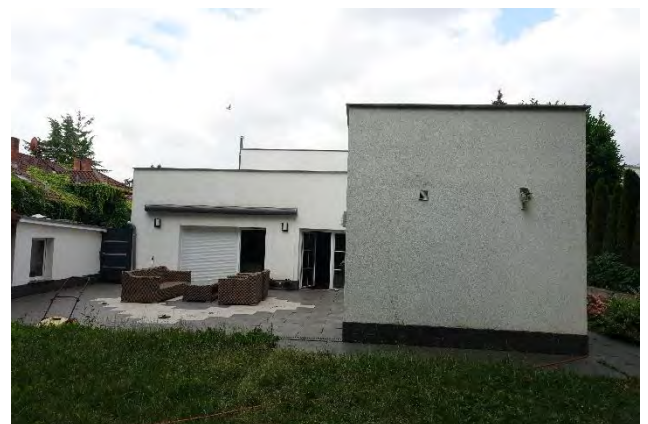
7.2.6 Garage und Ostfassaden, Blick vom Garten Richtung Westen
