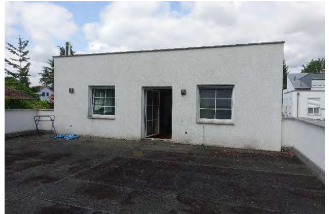
7.2.8 Ostfassade im Obergeschoss, Blick von der Dachfläche Anbau Richtung Westen
