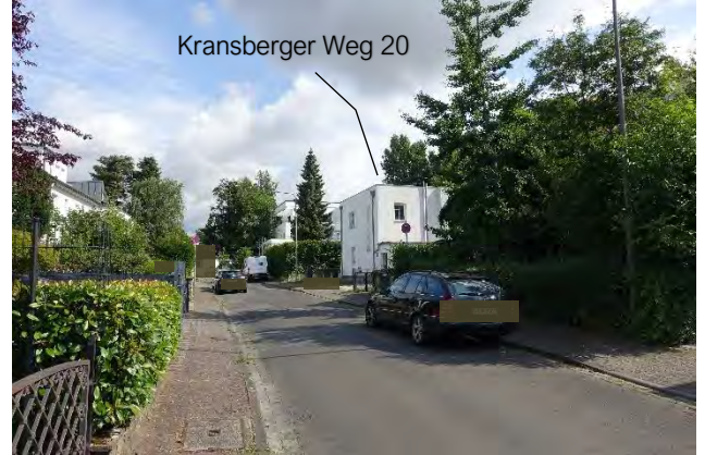
7.2.2 West- und Südfassade, Blick von der Straße Richtung Nordosten
