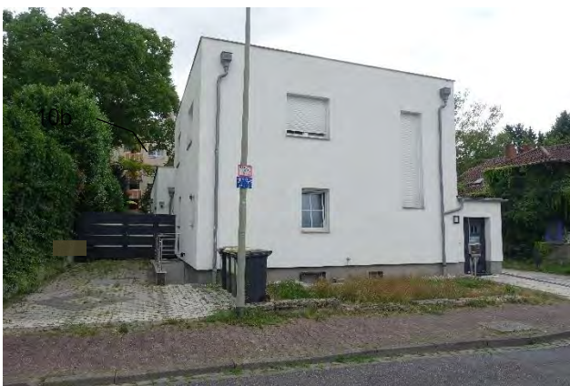
7.2.5 Westfassade, Blick von der Straße Richtung Osten
