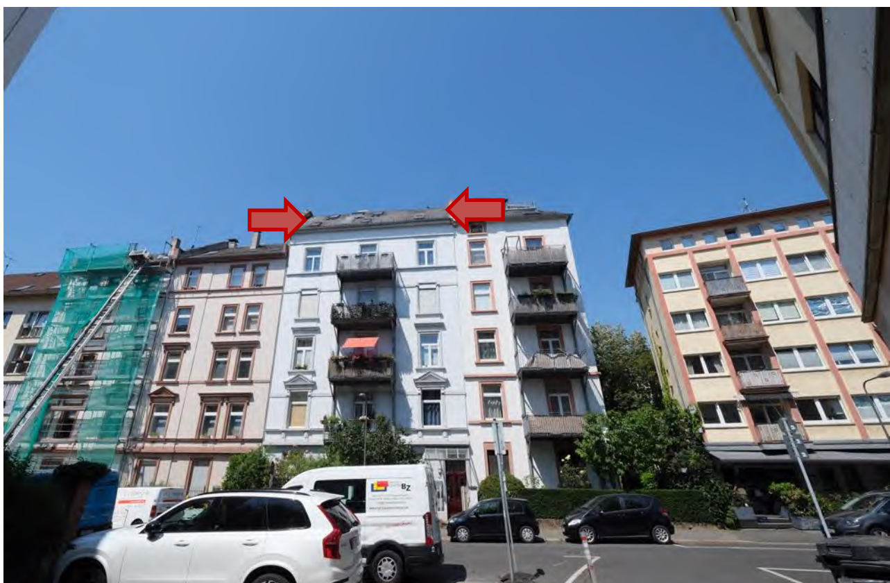
Ostfassade zur Luisenstraße.
