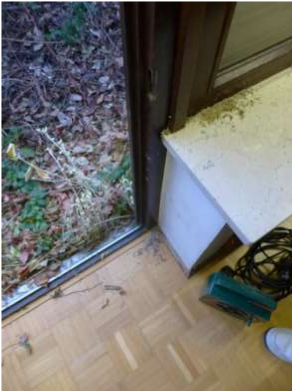
13 a Terrassenausgang Wohnzimmer
