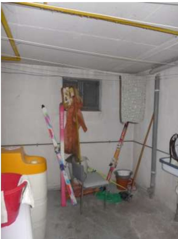
12 a Waschküche Kellergeschoss
