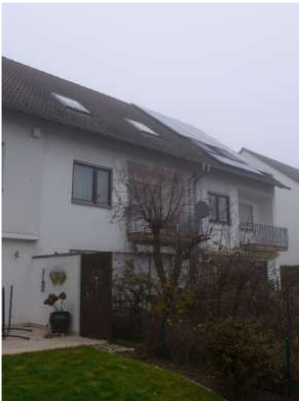
24 Rückansicht Wohnhaus (Südansicht)
