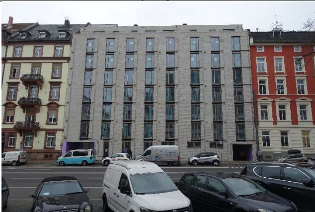
Ostfassade, Blick vom gegenüberliegenden Gehweg Richtung Westen
