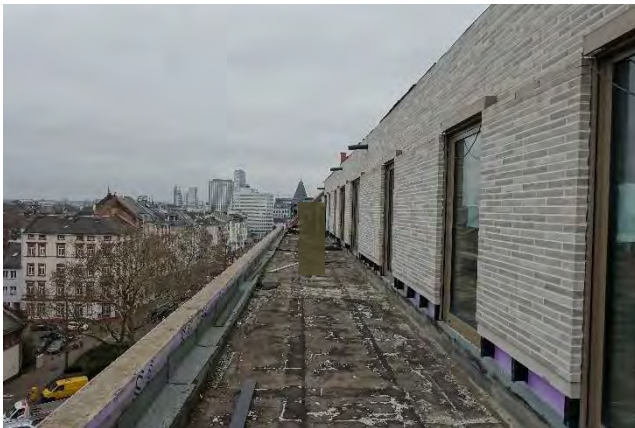
7.4.9 Künftige Terrassen im 7. Obergeschoss, Blick Richtung Süden
