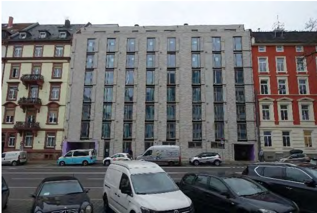
7.4.7 Ostfassade, Blick vom gegenüberliegenden Gehweg Richtung Westen
