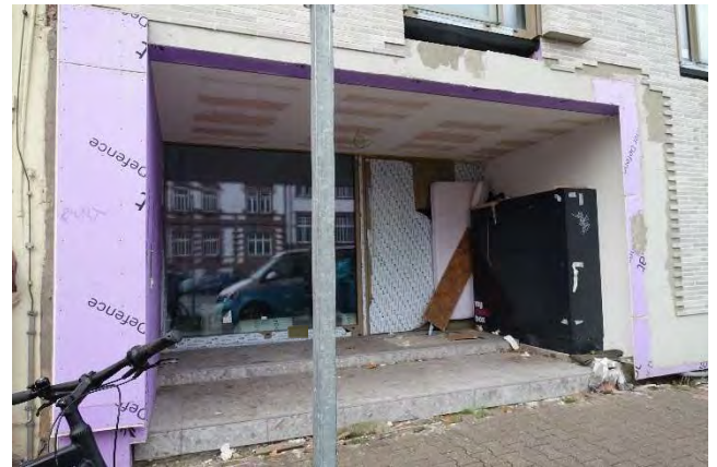
7.4.16 Hauseingang, Blick vom Gehweg
