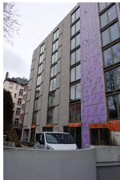
7.4.18 Westfassade, Blick vom Hof Richtung Nordosten
