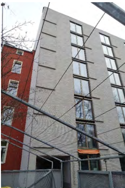
7.4.11 Westfassade, Blick vom Hof Richtung Südosten
