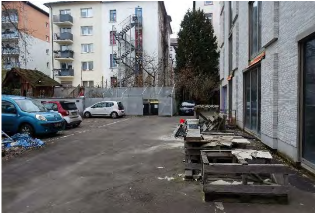
7.4.13 Hof, Stellplätze und Mülltonnebereich im westlichen Grundstücksbereich, Blick Richtung Norden
