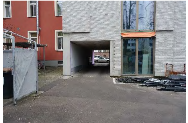
7.4.14 Teilbereich Westfassade, Durchfahrt von der Straße zum Hof, Blick Richtung Straße
