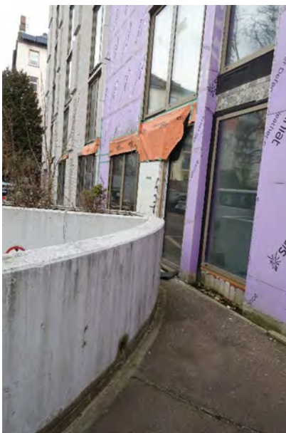
7.4.17 Westfassade, Blick vom Hof Richtung Nordosten
