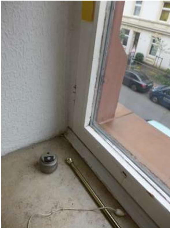
15 a Zustand Fenster 1. OG
