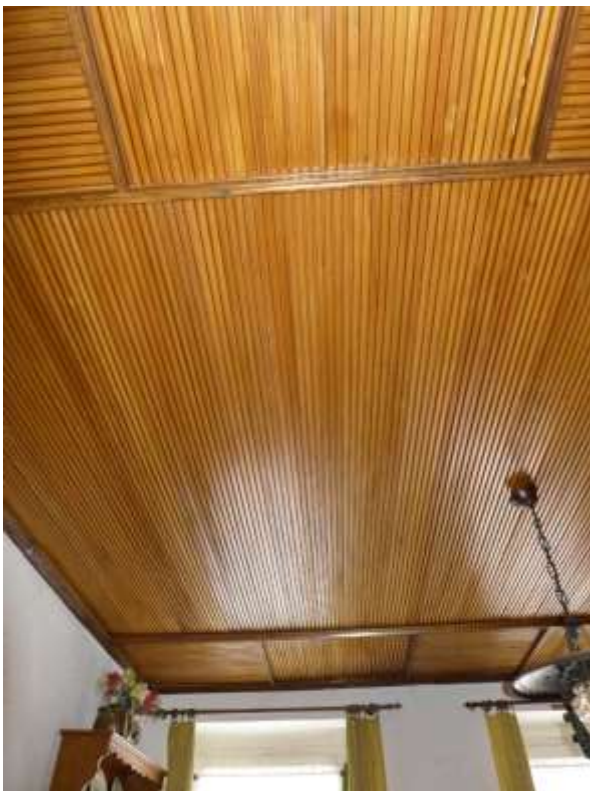
16 a Holzdecke 1. OG
