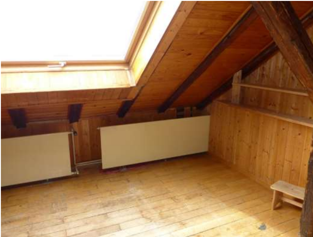
25 Heizkörper Spitzboden, Dachflächenfenster
