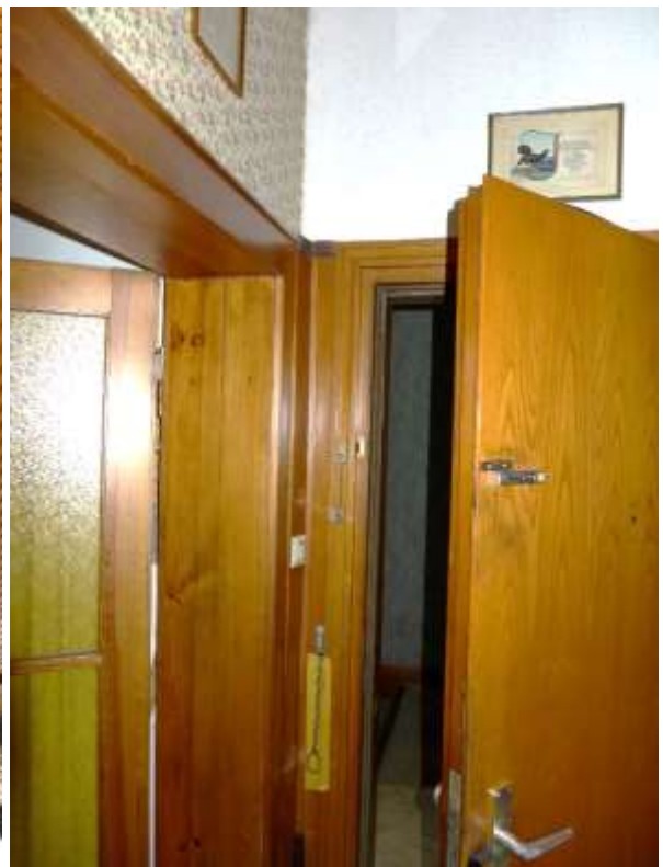
16 b Wohnungseingangs- und Innentür 1. OG
