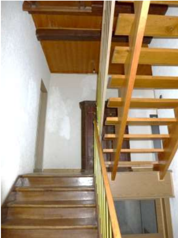
19 a Treppe zum 4. OG und Spitzboden
