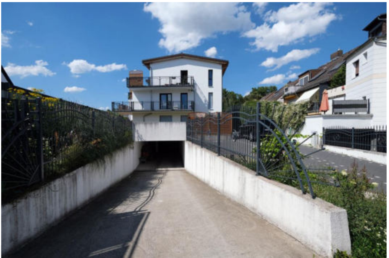
Tiefgarageneinfahrt zur Südseite, sowie Blick auf die Südfassade.
