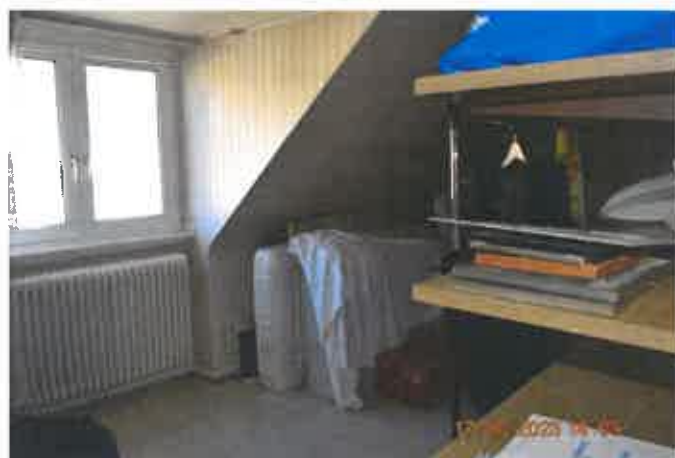
Zimmer (lt. Bauunterlagen Bodenraum) Dachgeschoss
