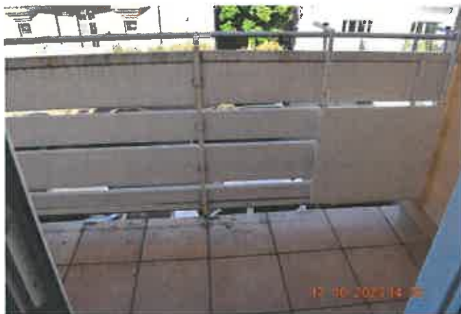
straßenseitiger Balkon 2. Obergeschoss
