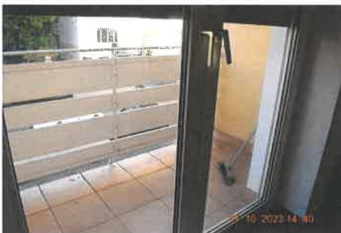
straßenseitiger Balkon 1. Obergeschoss
