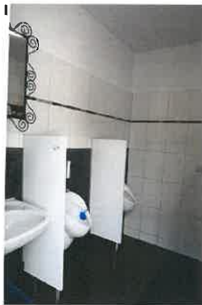
separate WC-Anlage im Anbau
