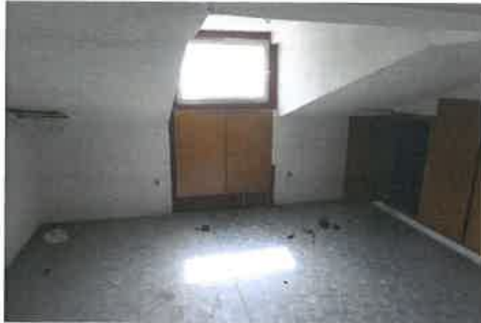
Raum im Dachgeschoss
