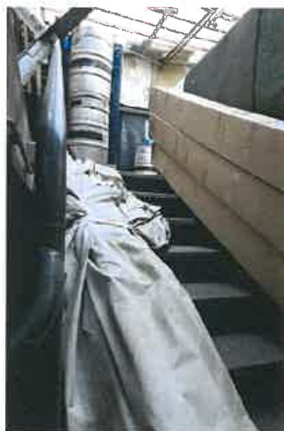
Treppenaufgang zu den Nebengebäuden/Überdachung vom Keller zum Erdgeschoss
