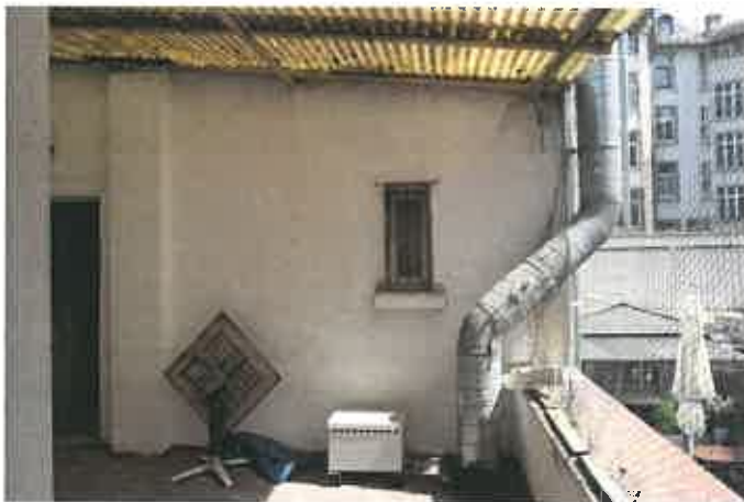
Außenansicht überdachte Freifläche Obergeschoss mit Küchenabluft
