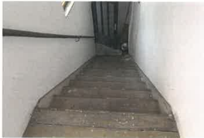
Treppenaufgang zum Obergeschoss vom Anbau aus
