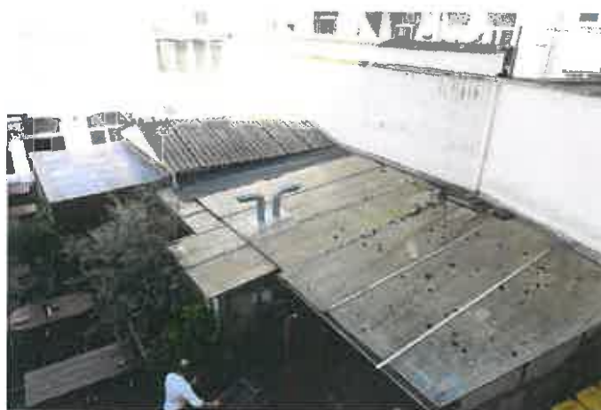
Dachflächen der ehemaligen Garage und Überdachungen
