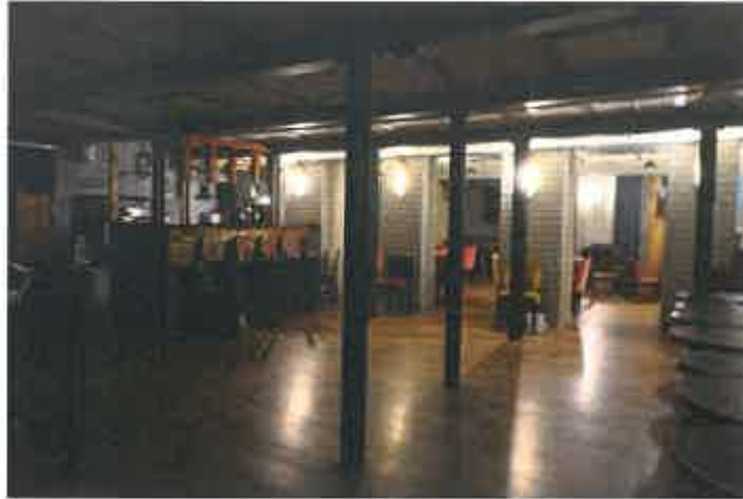
Gastraum Kellergeschoss (baurechtlich nicht genehmigt)
