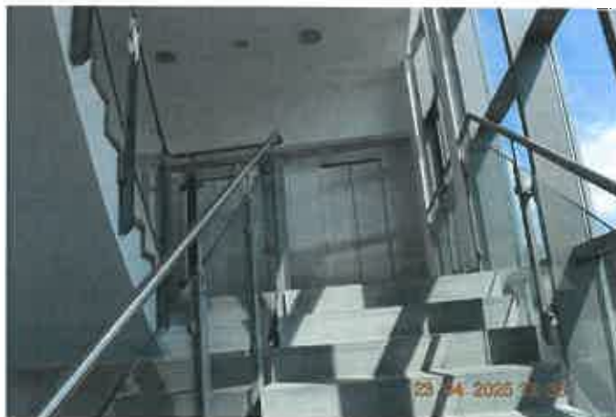
Treppenhaus mit Aufzugsanlage
