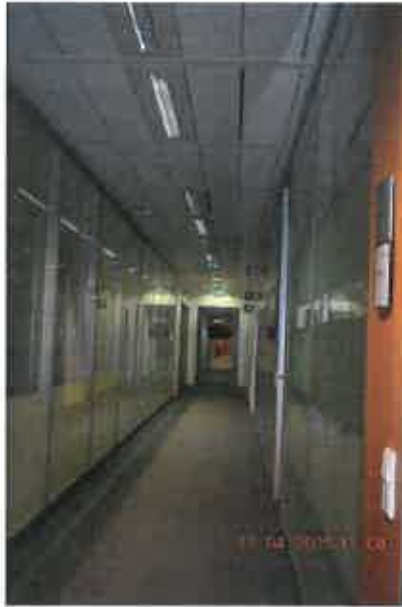
Gangbereich innerhalb einer Büroeinheit
