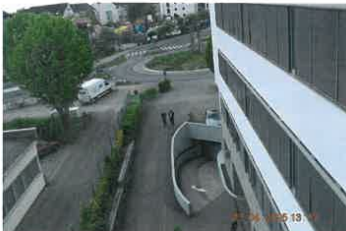
Draufsicht auf die vordere Zufahrt zur Tiefgarage
