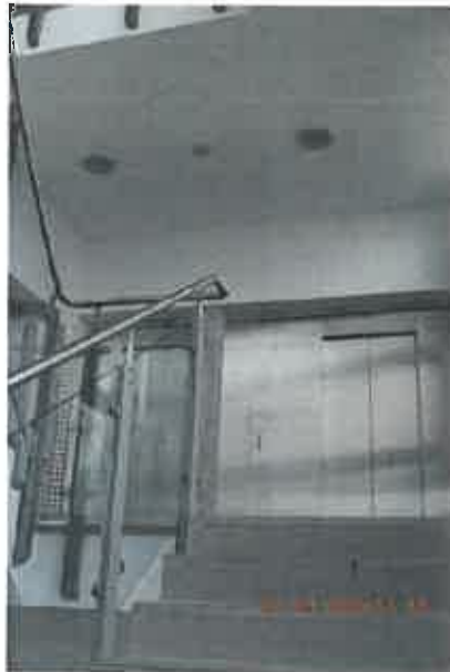
Treppenabsatz mit Aufzugsanlagen
