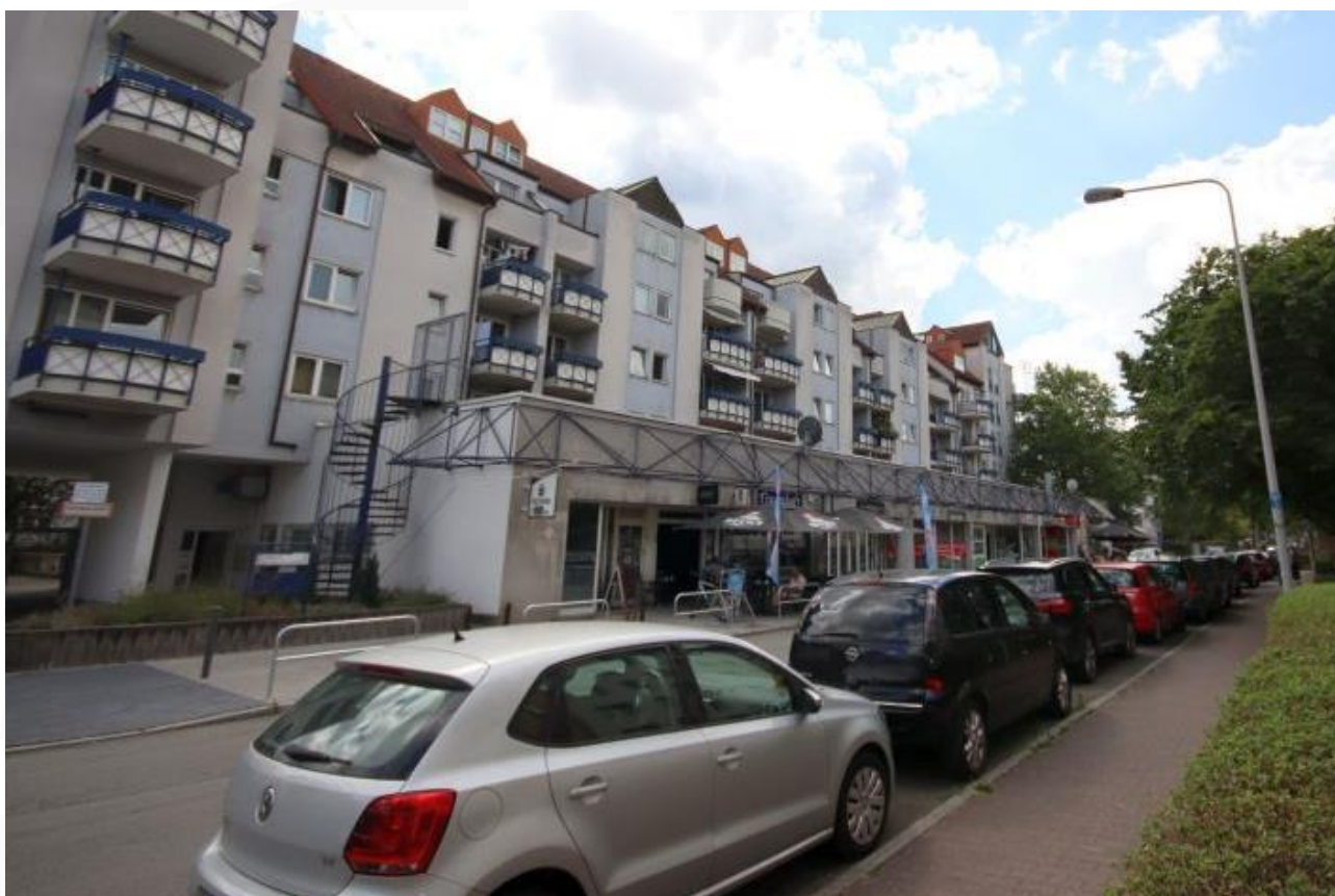
Gesamteindruck. Straßenfassade zur Melibocusstraße
