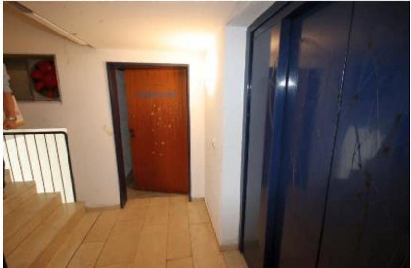
Die zum Teil defekte Beleuchtung des Treppenhauses stellt ein deutliches Stolperrisiko dar. Die Treppenhausbelüftung ist hier nicht funktionstüchtig. Horizontale Risschäden an der Geschossplatte zum 5. OG sichtbar. Vertikaler Fugenabriss in der Bauteilfügung zur Dachschräge. Dachflächenfenster bzw. Rauchabzugsanlage elektrisch gesteuert.
