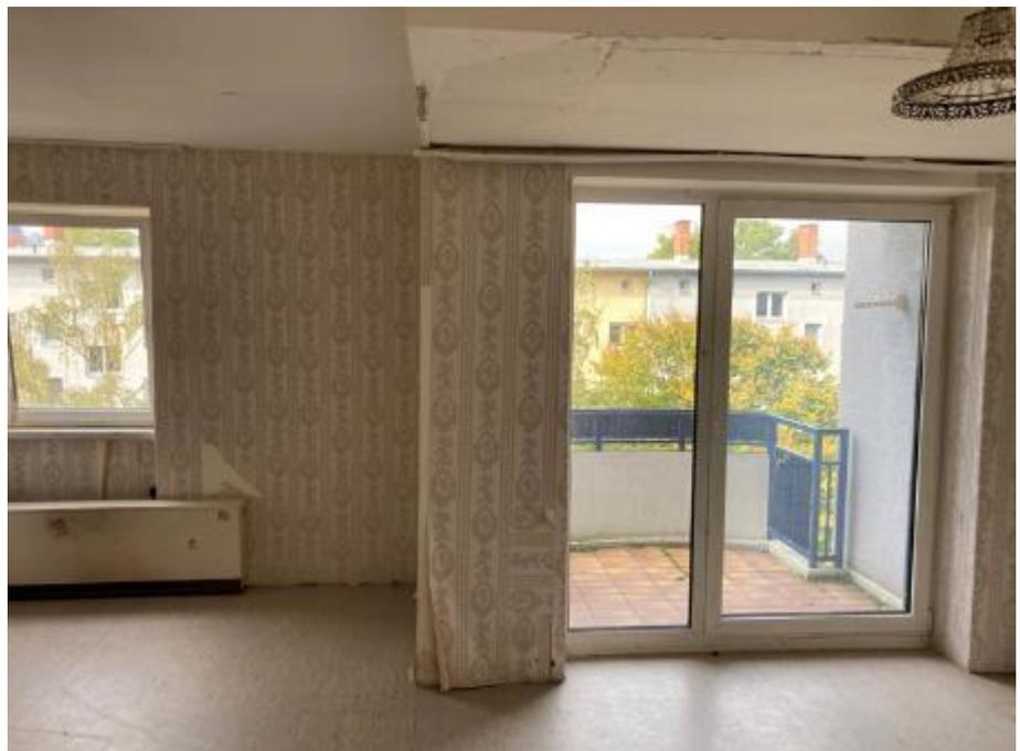
Bodenbelag: elastisch, könnte nach Grundreinigung wiedergenutzt werden. Innentüren: beschädigt/zerkratzt. Badezimmer innenliegen. Revisionsklappe zur Einbauwanne fehlt. WC stark verschmutzt. Gegensprechanlage nicht mehr vorhanden. Fenster: stark verschmutzt. Schimmelbefall an manchen Wandstellen. In einer Innenwand ist ein Loch, Glasfaserdämmung ist sichtbar. Sporenbefall im Abstellraum.
