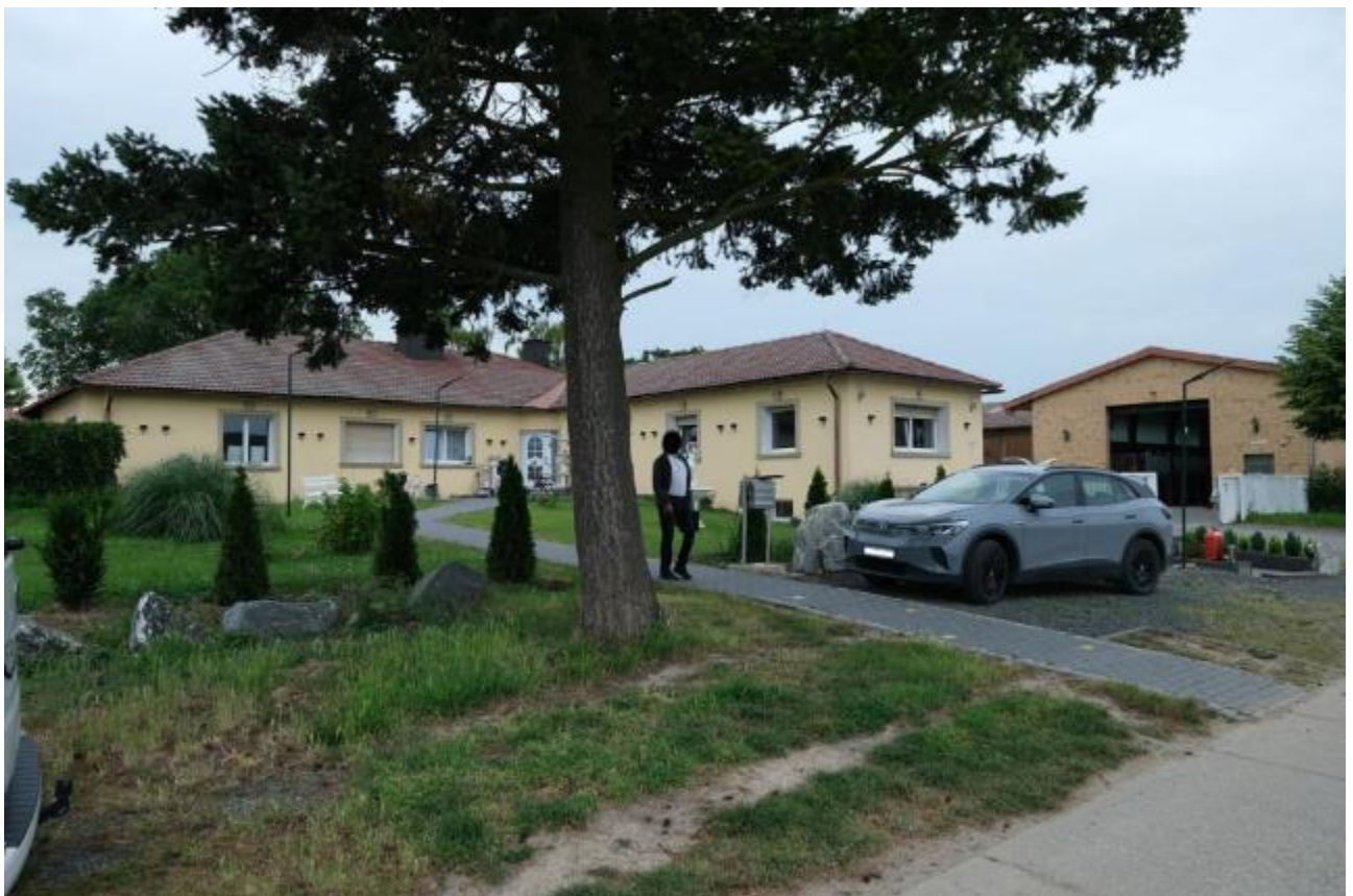
Blick auf das Wohnhaus
