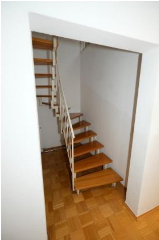
Interne Erschließung des Spitzbodens vom Dachgeschoss aus.
