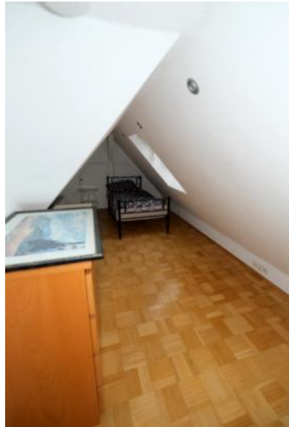
Ausgebauter Spitzboden mit sehr geringer lichten Raumhöhe
