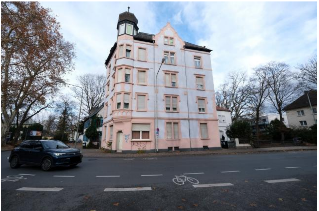
Blick auf die Liegenschaft Auf der Insel 2 bestehend aus 6 Eigentumswohnungen (eine Wohnung im Nebengebäude zur Nidda gelegen).
